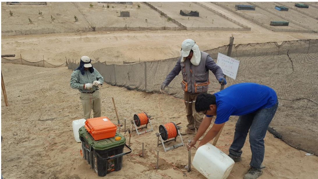
Foto n° 35: Realizando el humedecimiento del suelo.
