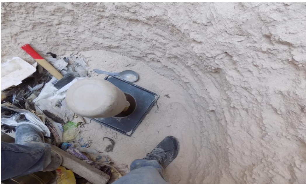
Foto n° 26: Realizando el ensayo de densidad in-situ a 3m de profundidad.
