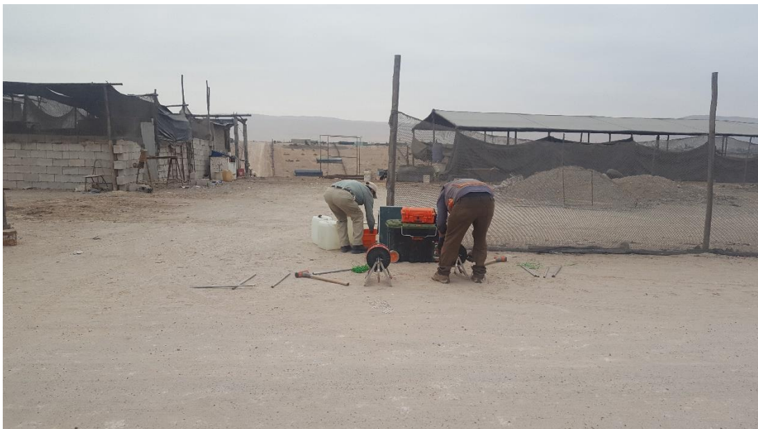
Foto n° 29: Preparando los cables para iniciar el ensayo.
