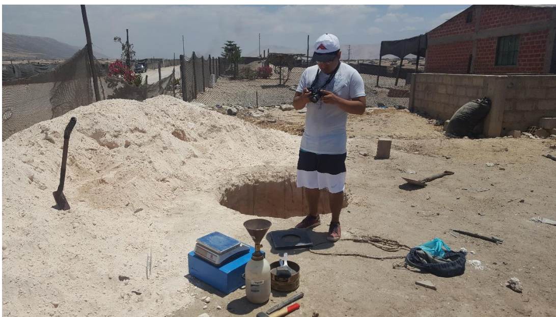
Foto n° 20: Equipos y herramientas para elaborar el ensayo de densidad in-situ.
