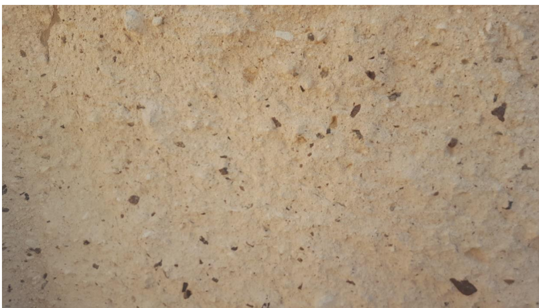
Foto n° 06: Inspección visual del estrato de la calicata.
