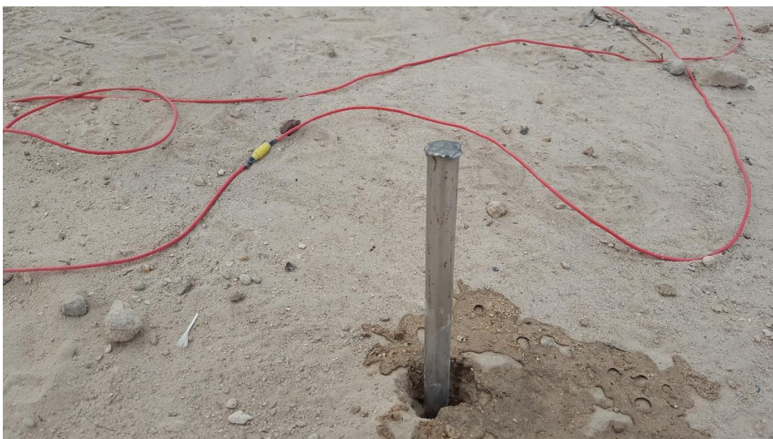
Foto n° 38: Realizando el clavado de las estacas con las herramientas requeridas.
