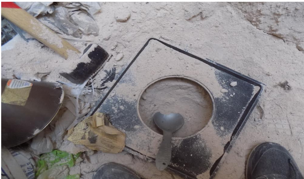
Foto n° 25: Realizando el agujero para extraer la muestra de densidad in-situ.
