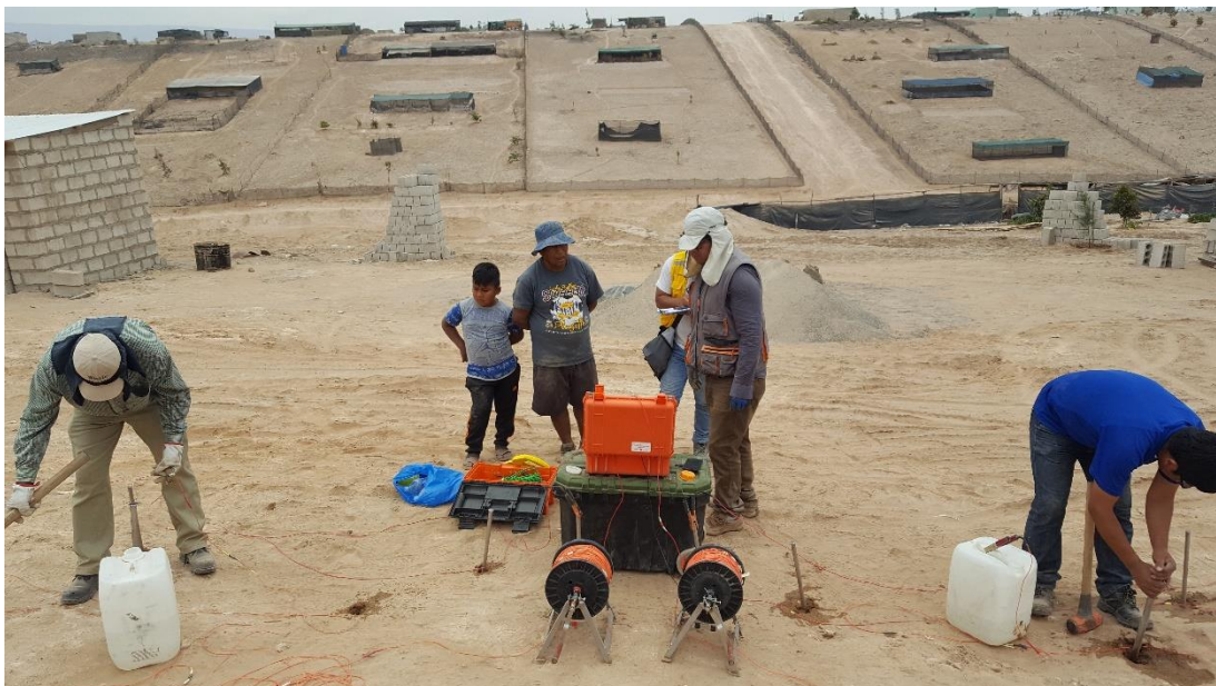
Foto n° 39: Realizando el clavado de las estacas con las herramientas requeridas.
