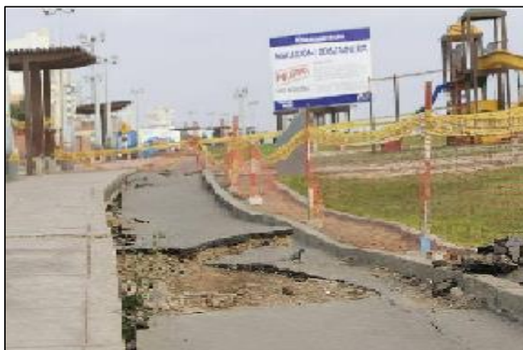
FIGURA 01. Construcción de Malecón Costanera
