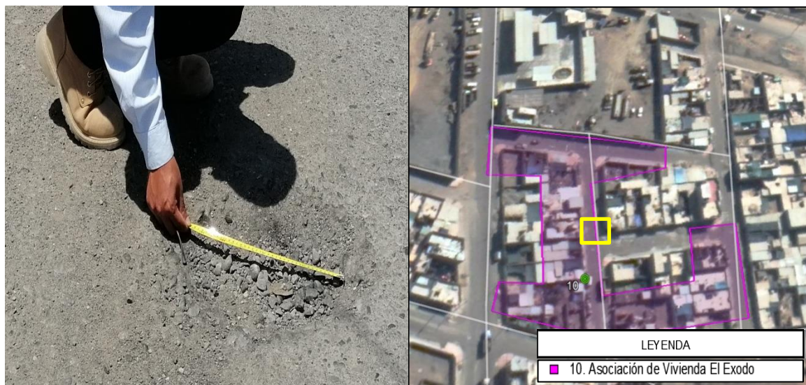
FIGURA 73. Presencia de desgaste en la vía (fallas por desgaste) y ubicación satelital
