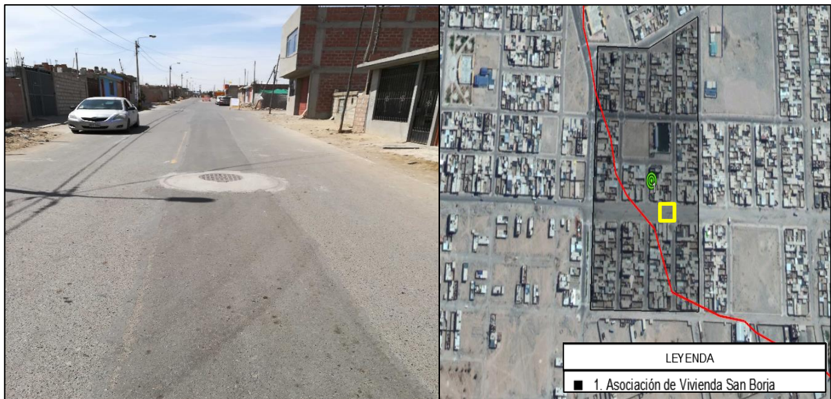
FIGURA 55. Buzones de la conexión de alcantarillado en la vía
