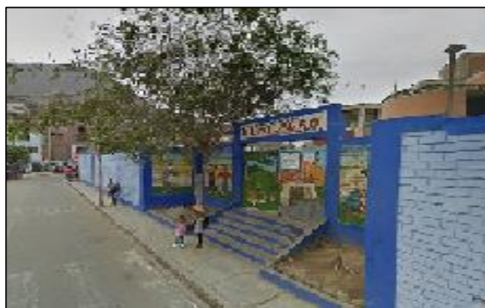
FIGURA 03. Construcción I.E Cuna Jardín “El Milagro”, Lima
