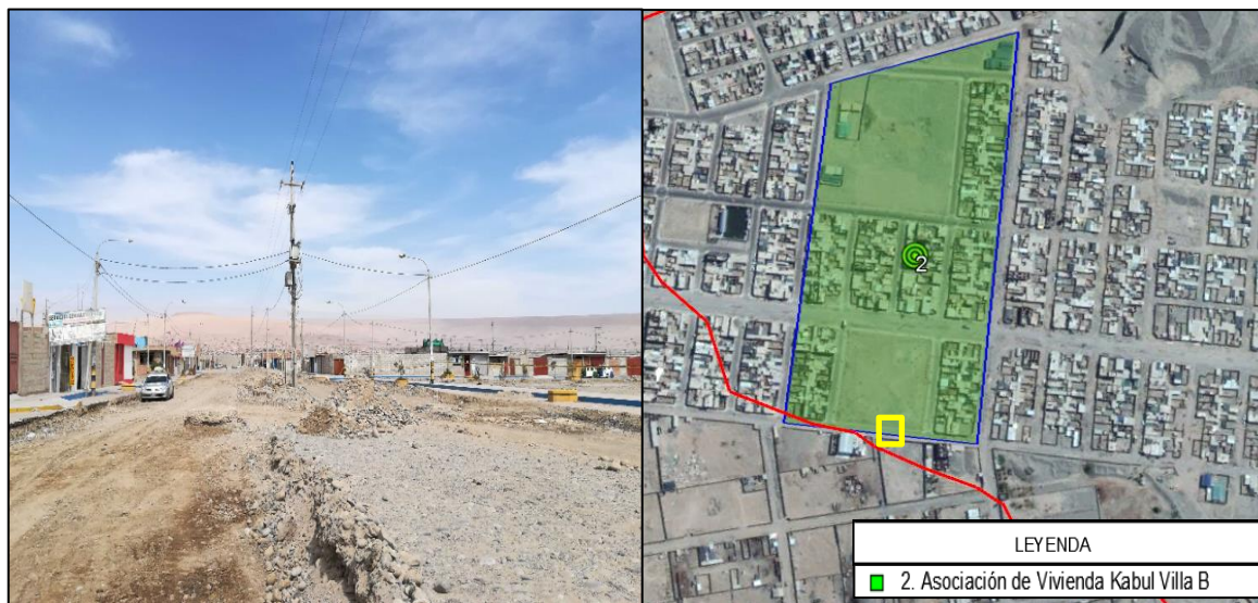
FIGURA 59. Avance de obra de la avenida (presencia material suelto)
