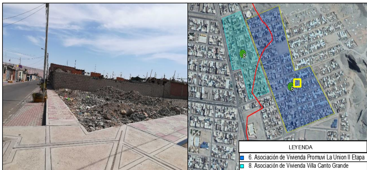
FIGURA 57. Veredas y bermas construidas con adoquines en algunos sectores
