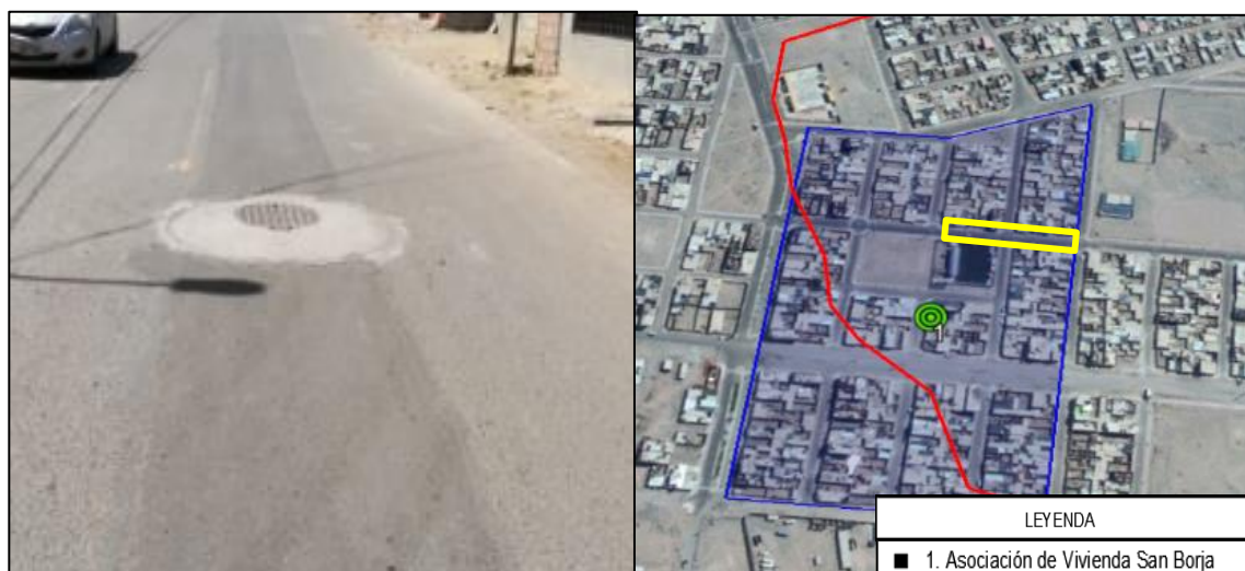
FIGURA 78. Presencia estructura vial en la zona y ubicación satelital
