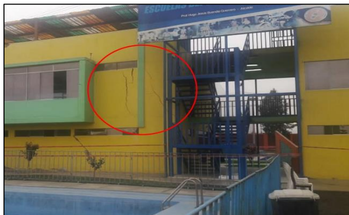
FIGURA 02. Construcción de Polideportivo Municipal, Ica
