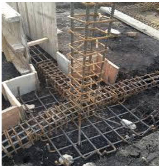
Figura N°2.10. Zapata lineal o llamada zapata corrida.
