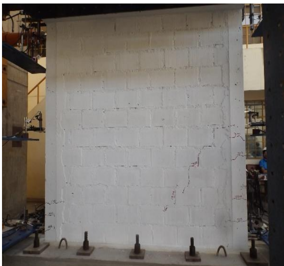
Figura N°4.3. Aparición de grietas diagonales en el mortero en el lado este de las caras Norte y Sur a una distorsión 1/1500.
