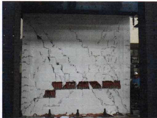
Foto 32. Desprendimiento de un ladrillo en la parte central Oeste de la cara Sur para una distorsión de 1/150 en el 1° ciclo.
