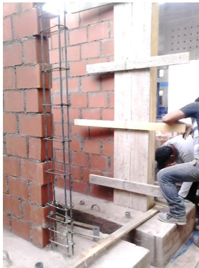
Figura N°3.4. Encofrado de columna.
