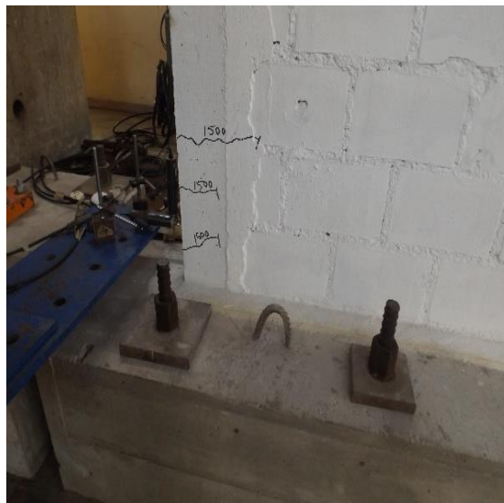
Figura N°4.1. Formación de primeras grietas para una distorsión 1/1500.
