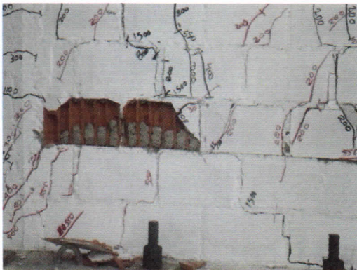
Foto 96. Desprendimiento de ladrillo en la parte inferior Oeste de la cara Sur para una distorsión de 1/150.
