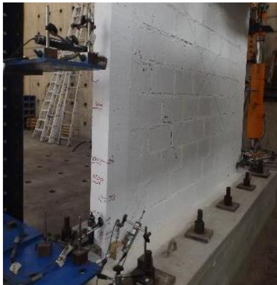
Figura N°4.2. Grietas en la parte central de la columna Este para una distorsión 1/1500.
