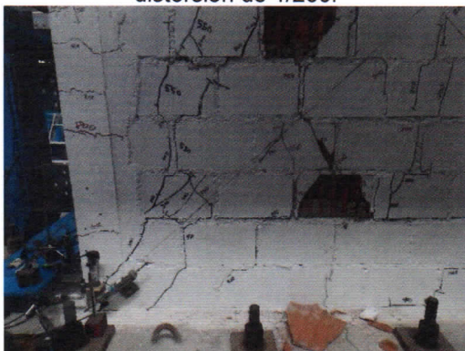
Foto 88. Desprendimiento de ladrillo en la parte inferior Este de la cara Norte para una distorsión de 1/200.
