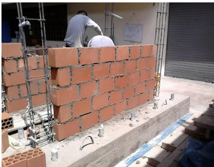
Figura N°3.3. Dentado del Muro.
