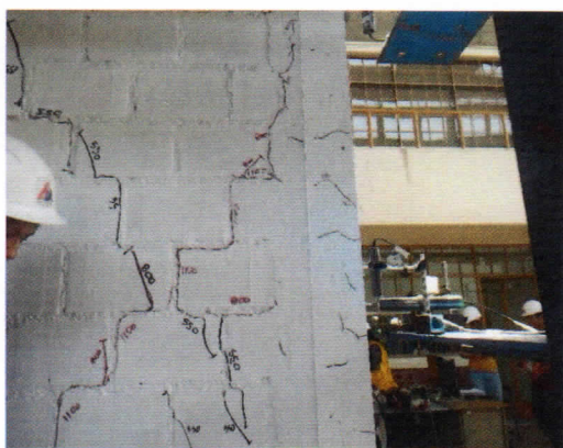
Foto 62. Formación de grietas diagonales en el lado Este de la cara Sur para una distorsión de 1/550.
