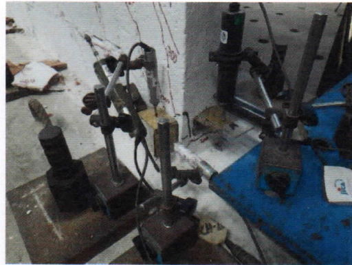
Foto 85. Formación de grieta en la parte inferior de la columna Este para una distorsión de 1/200.
