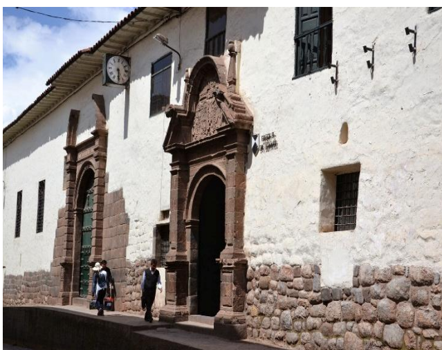
Figura N°2.9. Antigua Casona de adobe en Cusco. (Calle San Bernardo)
