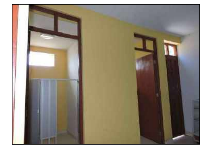
Fisura longitudinal frontal en la viga EJE 3-3 entre EJE D-F
