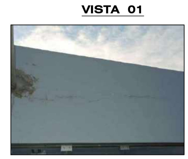
Fisuras longitudinales y transversales de la parte exterior del salón de juegos, sección de viga en el EJE G-G entre EJE 3-5
