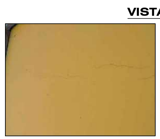
Fisura longitudinal frontal de la entrada al salón de juegos en el EJE 3-3 entre EJE F-G
