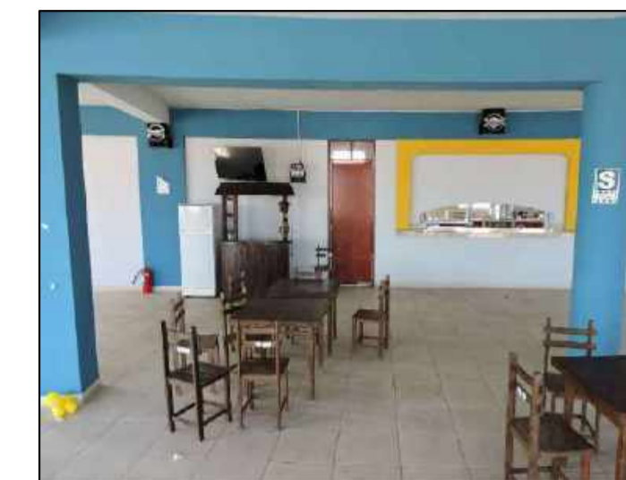
Fisuras longitudinales y transversales en el portico ubicado en el EJE 2-2 entre EJE B-C
