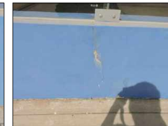
Fisura transversal en el sobrecimiento parte externa del ambiente del EJE 5-5 entre EJE C-F
