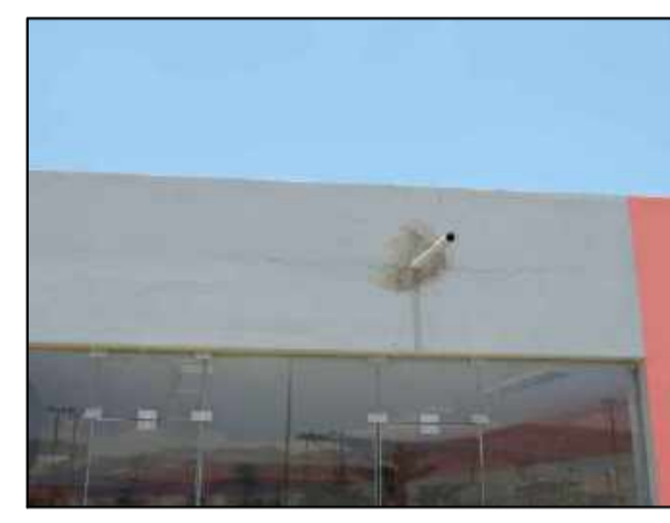
Fisuras longitudinales y transversales de la parte exterior del salón de juegos, sección de viga en el EJE G-G entre EJE 3-5
