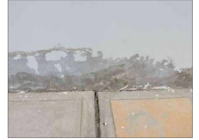
Fisuras, Desprendimiento y humedad en las veredas del complejo recreacional
