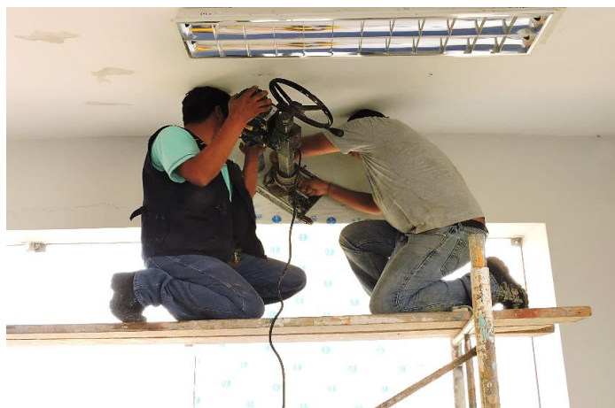
Figura 27. Extracción de testigos de concreto
