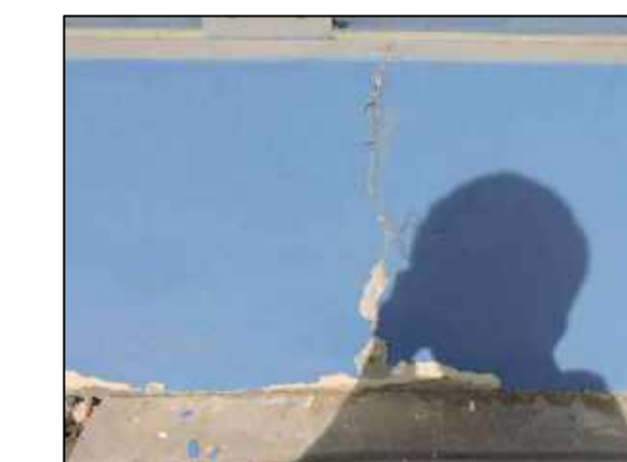
Fisura transversal en el sobrecimiento parte externa del ambiente del EJE 5-5 entre EJE C-F
