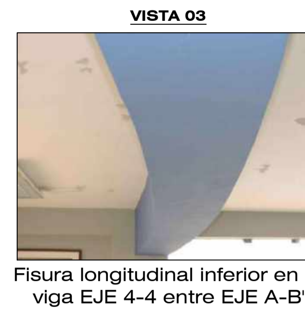
Fisura longitudinal posterior en la viga EJE 4-4 entre EJE A-B'
