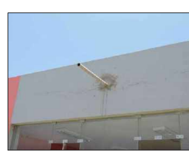
Fisuras longitudinales y transversales de la parte exterior del salón de juegos, sección de viga en el EJE A-A entre EJE 3-4
