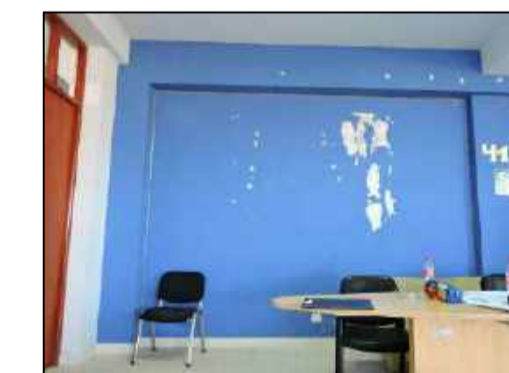
Fisuras longitudinales y transversales en el portico ubicado en el EJE G-G entre EJE 3-4
