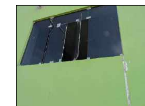
Detalle de fisuras en las parte superior de la ventana
