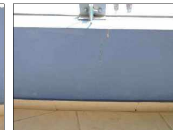
Fisura transversal en el sobrecimiento parte interna del ambiente del EJE 5-5 entre EJE C-F
