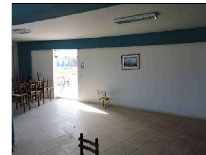
Fisuras longitudinales y transversales en el portico ubicado en el EJE 2-2 entre EJE A-B
