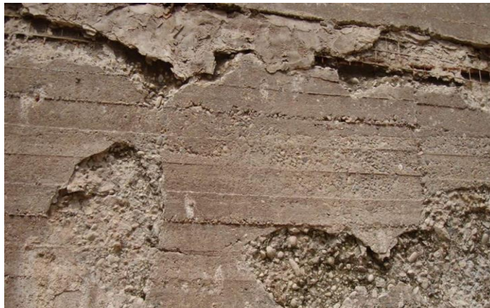
Figura 10. Desgaste superficial - erosión por abrasión
