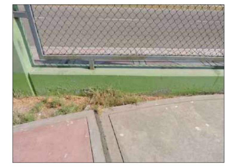
Fisuras, Desprendimiento y humedad en las veredas del complejo recreacional
