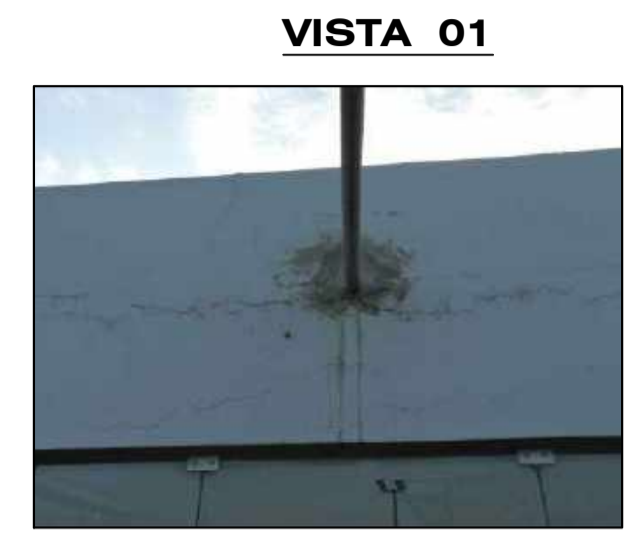
Fisuras longitudinales y transversales de la parte exterior del salón de juegos, sección de viga en el EJE A-A entre EJE 3-4
