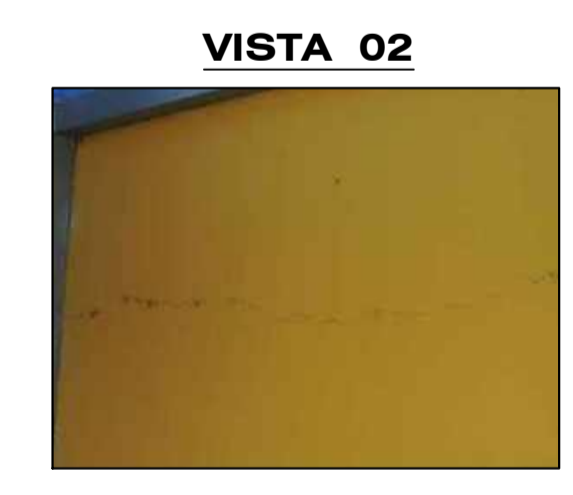
Fisura longitudinal frontal en la placa en el EJE 3-3 entre EJE A-B
