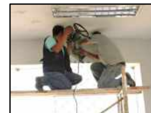
(4) Cuarta muestra de concreto extraída del salón de juegos
