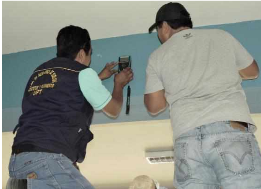
Fotografía 1. Detección del acero en estructuras de concreto armado
