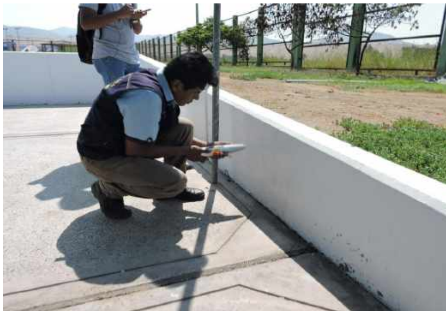
Fotografía 14. Resistencia de sardinales en zona de piscina utilizando el esclerómetro
