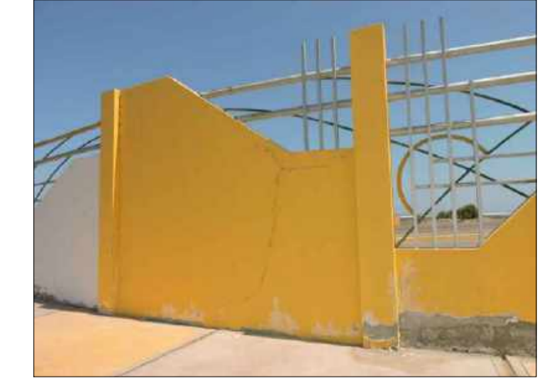
Fisuras, Desprendimiento y humedad en las veredas del complejo recreacional
