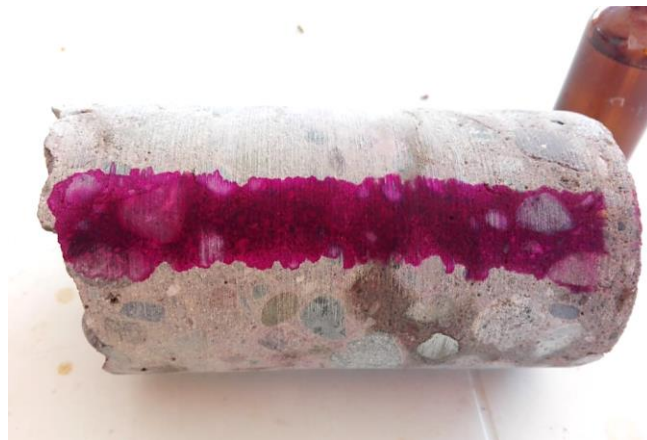
Figura 15. Carbonatación del concreto - aplicación de la fenolftaleína
