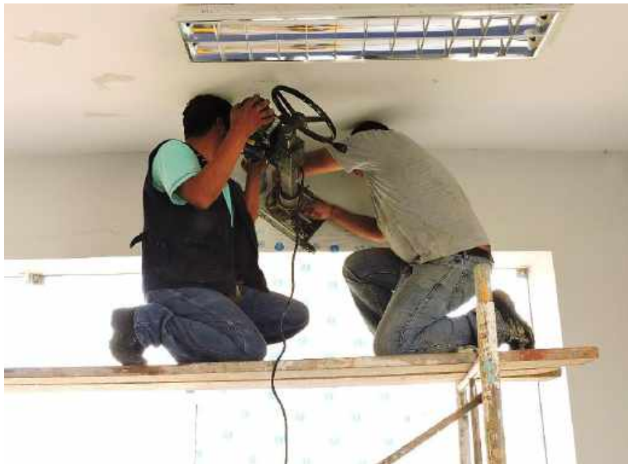
Fotografía 2. Extracción de diamantina de concreto
