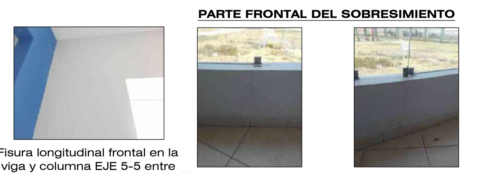
Fisuras transversales en el sobrecimiento ubicado en el EJE 5-5 entre EJE A-B'
