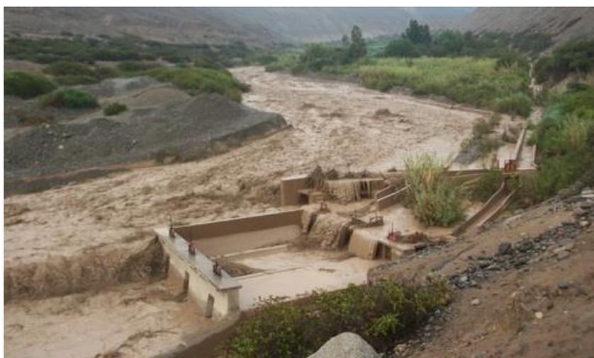
Nota. En la figura 4 se aprecia el desborde por Huaico de la Bocatoma Calientes en el Distrito de Pachía, año 2012. Tomado de Radio Uno Tacna.
