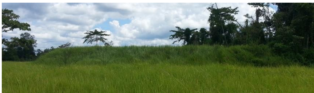
Gambar 7. Kondisi Revetmen di kawasan Kendari II Airfield (Lanud HLO)
