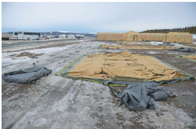
Рис. 1. Развертывание полевого лагеря после выравнивания и очистки территории от снега.
