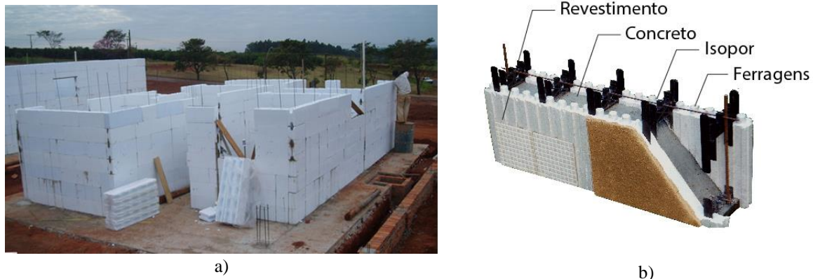
Figura 1 – a) Sistemas ICF sendo executado em obra; b) Detalhamento da execução do sistema
