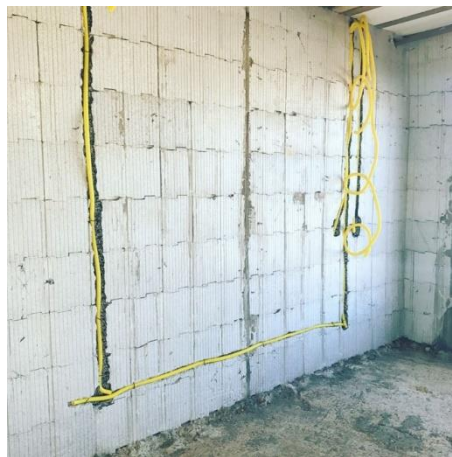
Figura 3 – Instalação elétrica embutida na fôrma
