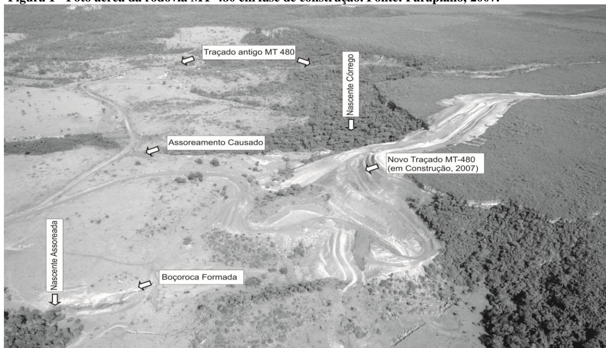
Figura 1 - Foto aérea da rodovia MT-480 em fase de construção. Fonte: Paraplano, 2007.
