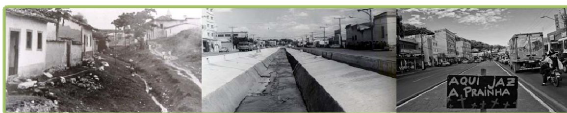
FIGURA 5. Lançamento “in natura” dos esgotos doméstico produzidos pela população diretamente no córrego da Prainha em 1940, década de 60/70 e atual. Fontes: Conte et al.,2005; MISC, 2012; Foresti, 2011.
