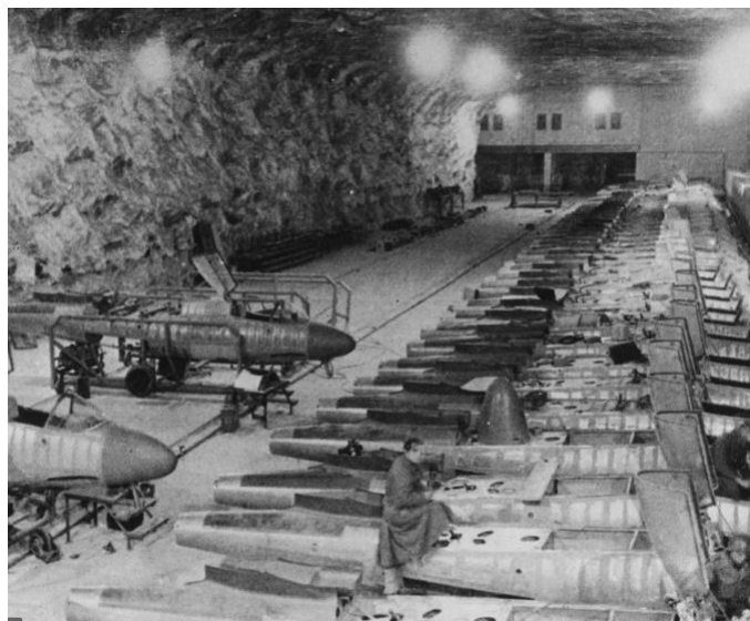
Figura 2.3 Vista de la Factoría Hinterbrühl en Abril de 1945 [2].
