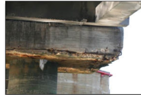
Ilustración 46: P 12. Hormigón de recubrimiento de armados deteriorado. Armadura en avanzado estado de corrosión
