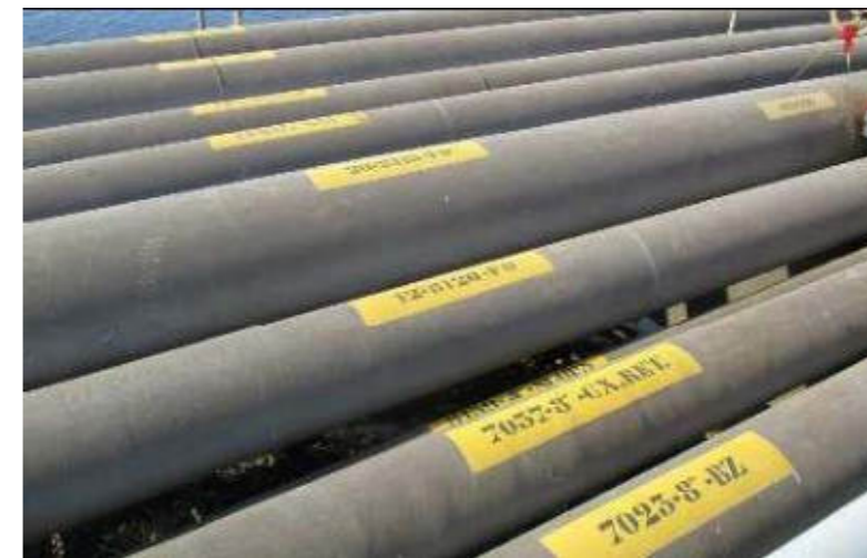
Ilustración 32 Imagen de tubos existentes en lado izquierdo de la pasarela de acceso
