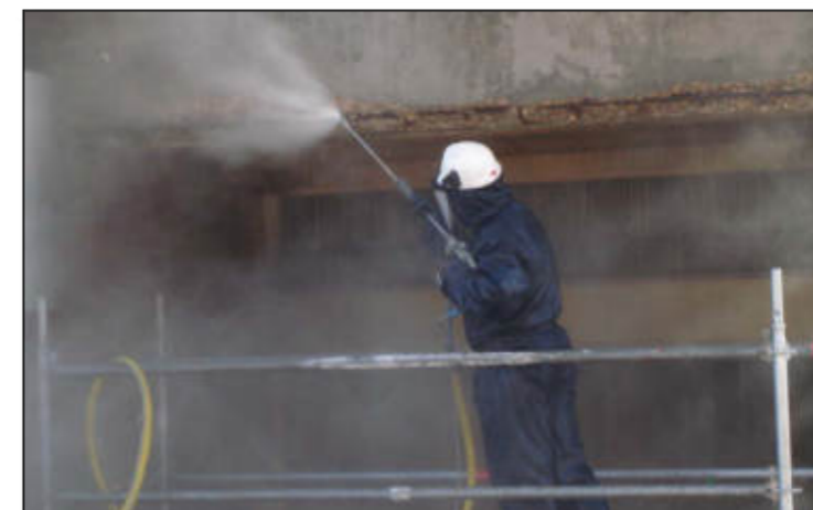
Ilustración 2: Fotografía de proceso de hidrodemolición
