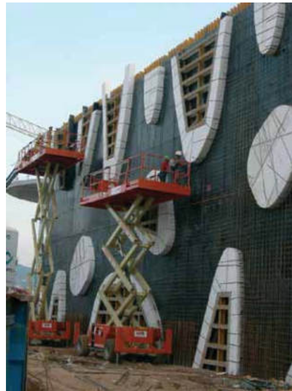
▲ Acabados de gran calidad en muros vistos obtenidos con el tablero fenólico en el encofrado vertical ENKOFORM V-100
