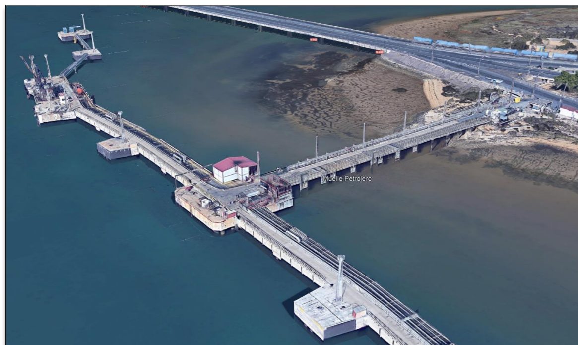
Ilustración 6 Vista aérea Muelle de graneles objeto de refuerzo estructural. (Fuente: Google Earth)
