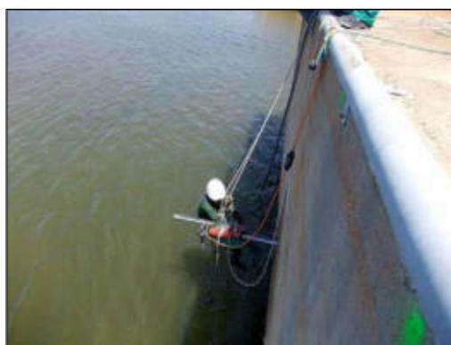
Ilustración 9: Extracción de testigos en paramento vertical
