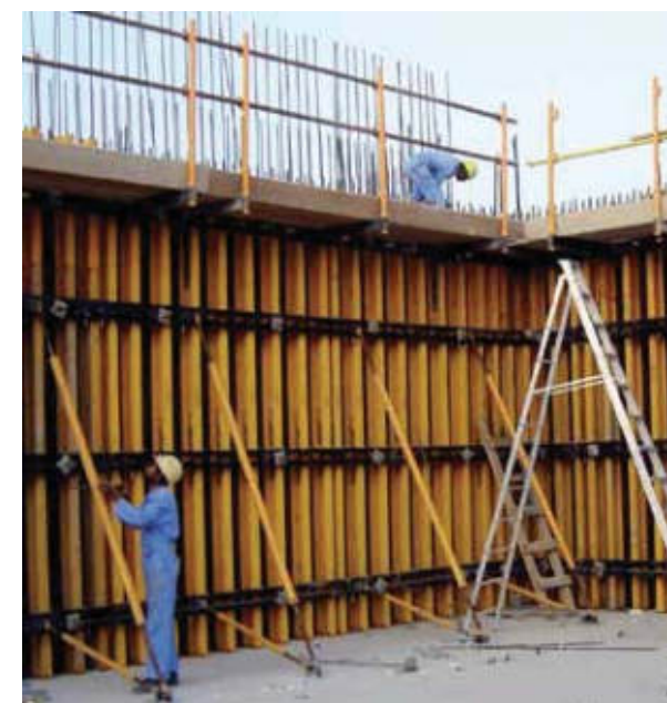
▲ Vigas VM-20 en el encofrado vertical ENKOFORM V-100 ▲
