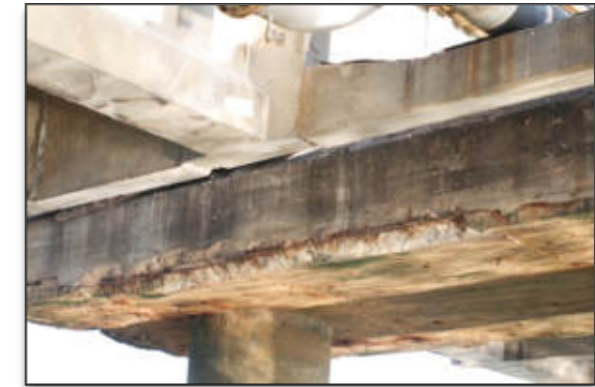
Ilustración 46: P 12. Hormigón de recubrimiento de armados deteriorado. Armadura en avanzado estado de corrosión
