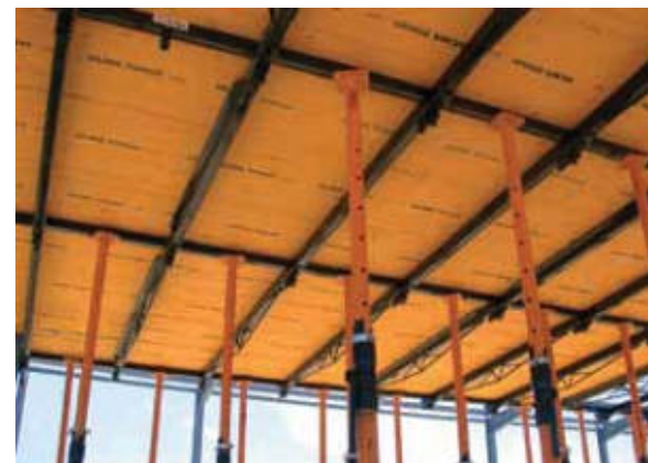
▲ Tablero Tricapa Trimax en el encofrado horizontal RAPID ▲
