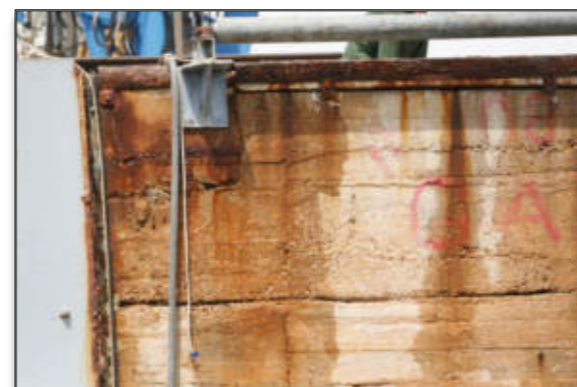
Ilustración 31: Atraque I cara C. Cintón protector de cabos de amare oxidado
