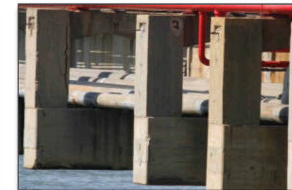
Ilustración 47: Atraque II: Hormigón de los pilares – soportes con avanzado estado de deterioro.
