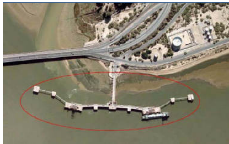
Ilustración 1: Situación del Muelle Petrolero
