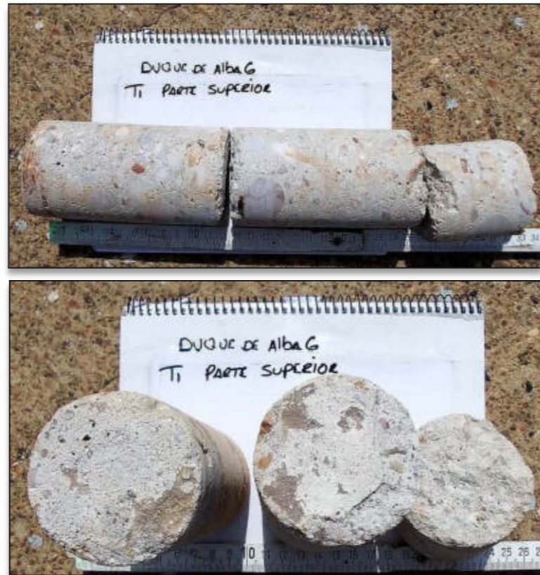
Ilustración 23: Duque de Alba 6. Testigo con presencia de junta de hormigonado no tratada a los 13 cm de espesor
