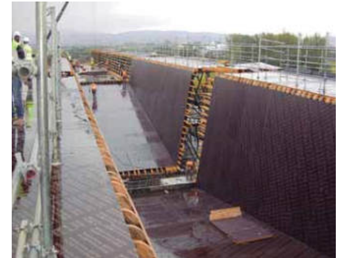
▲ Tablero fenólico como superficie encofrante en el encofrado ENKOFORM H-120 en la ejecución de viaducto
