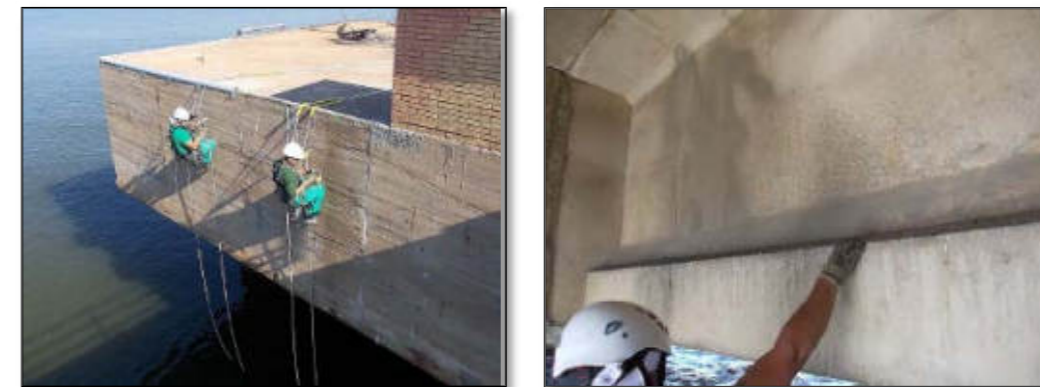
Ilustración 3: Fotografías de inspecciones (Fuente aportaciones Puerto de Huelva)
