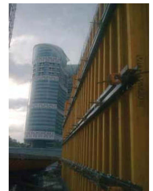
▲ Vigas VM-20 en el encofrado vertical ENKOFORM V-100 ▲
