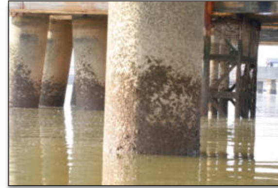
Ilustración 43: Estructura metálica protección conducciones
