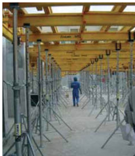
▲ Vigas VM-20 en el encofrado horizontal ENKOFLEX
