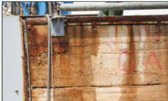
Ilustración 39: Cintón de protección de cabos de amarre
