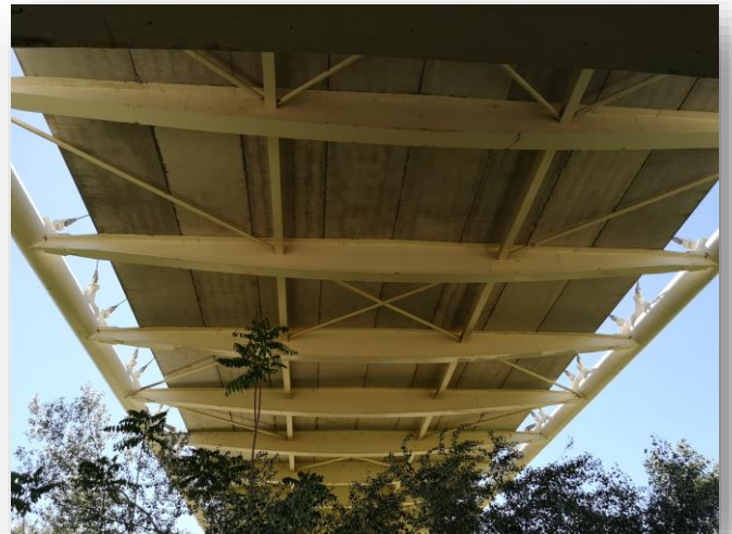
Figura 4. Referencia viga transversal
