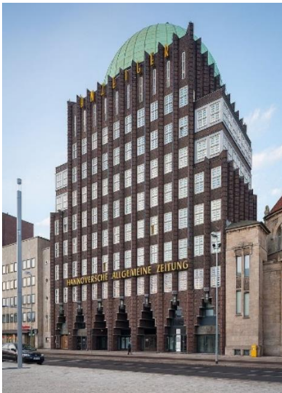
Figura 34: Anzeiger Hochhaus, 1927-28, Hanover, Fritz Höger
