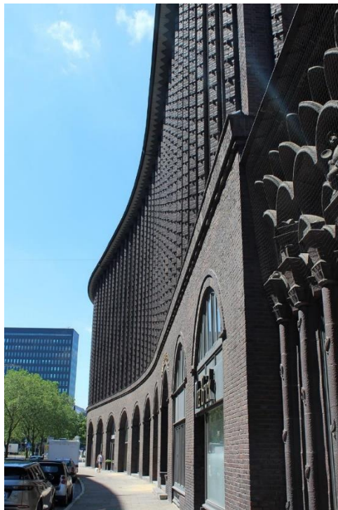
Figura 45: Fachada sur, efecto ladrillo
