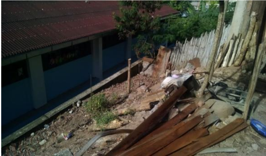
Figura 22. Fotografía del muro de contención voladizo estabilizando talud.
