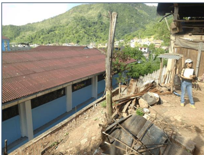
Figura 21. Fotografía del asentamiento humano encima del relleno del muro de contención
