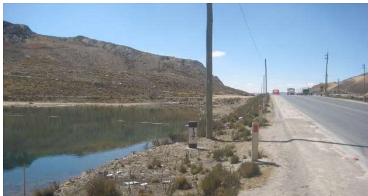
Figura N° 9 Fin de la investigación de levantamiento de rasante km 136+729, existe un desfase de 270m entre las progresivas del Hito y las progresivas de puesta a punto.
