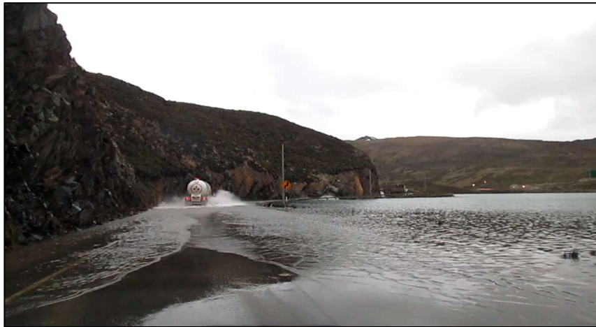
Figura N° 1 marzo del 2013, la Carretera Central sufrió la inundación de la plataforma por aumento del nivel de la laguna Churuca.
