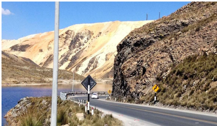
Figura N° 19 Afloramiento ígneo a la altura de la progresiva Km 136+080, sobre el talud superior, el mismo que se proyecta en el talud inferior (línea entrecortada roja).
