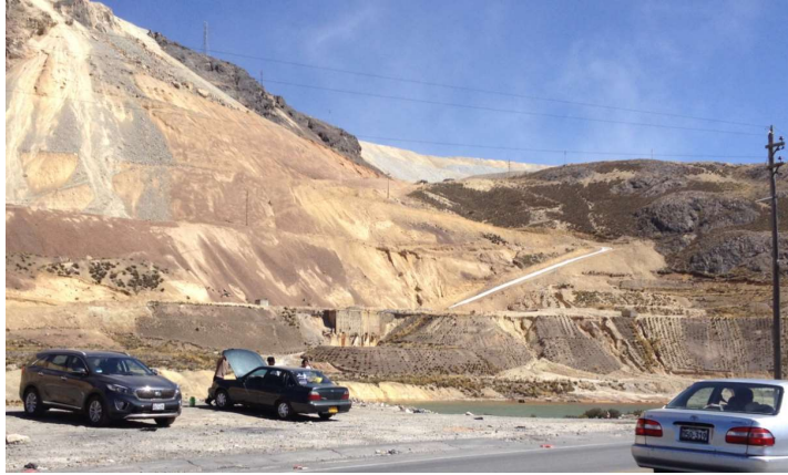
Figura N° 21 Vista panorámica de los depósitos antrópicos que se ubican sobre el talud superior, producto de la actividad minera del lugar.
