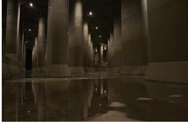
FIGURE 1.26 – Réservoir géant à Saitama dans la banlieue de Tokyo [6]
