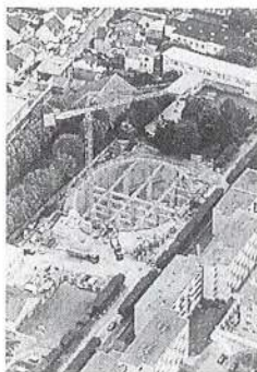
Figure 3: Construction d'un bassin de retenue au Blanc-Mesnil
