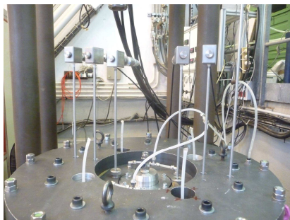
j – installation des capteurs de pression interstitielle
