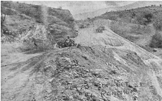
Imagen 4 Apertura de la brecha entre Sunzapote y Teculután. Sector 4 Ruta al Atlántico. Evidencia la maquinaria que se estaba utilizando.
