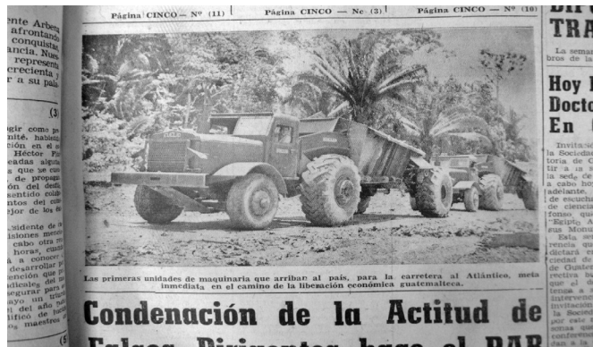
Imagen 2 Anuncio de la llegada de las primeras unidades de maquinaria para la carretera al Atlántico. Diario de Centroamérica, 18 de abril 1952 pág. 1.
