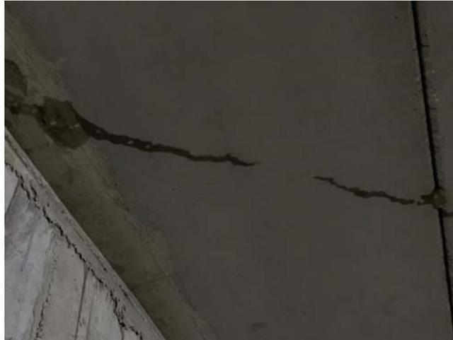
*Figura 63: Filtración de agua. Fuente: Elaboración propia*
