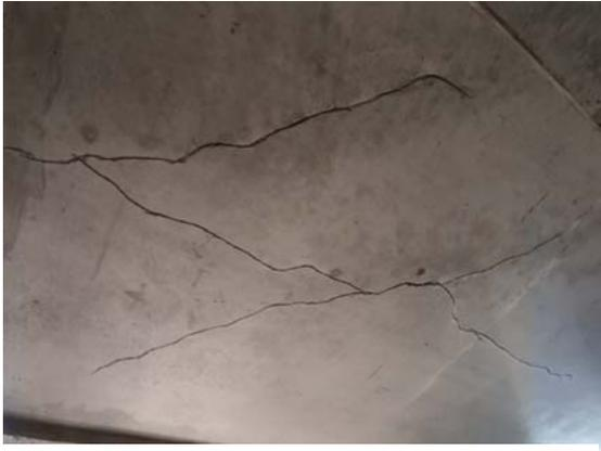
*Figura 45: Fisura en prelosa. Fuente:*
