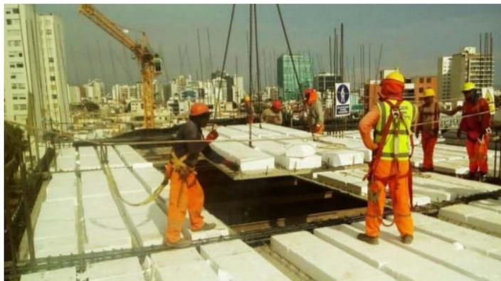
*Figura 2: Instalación de pre losas Betondecken.
