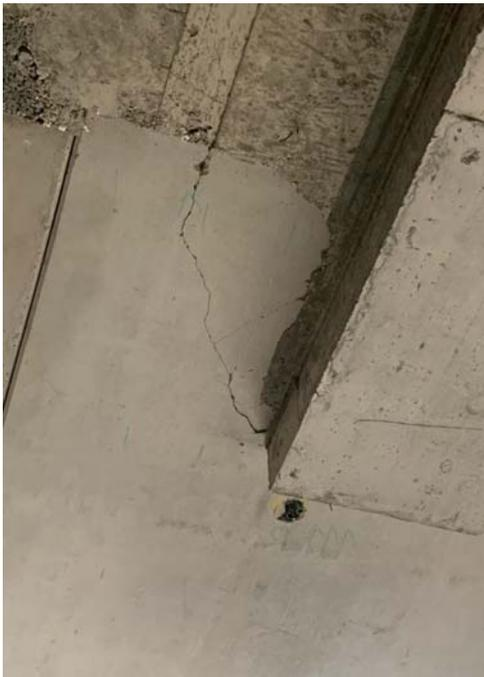
*Figura 43: Fisura en prelosa. Fuente:
