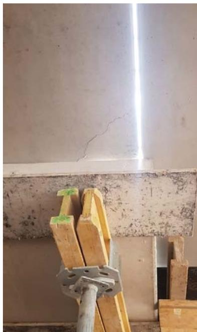
*Figura 53: Microfisuras por mal apuntamiento. Fuente:Elaboracion Propia*
