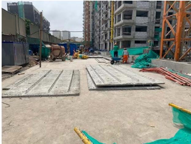
*Figura 52: Acopio inadecuado. Fuente:Elaboracion Propia*
