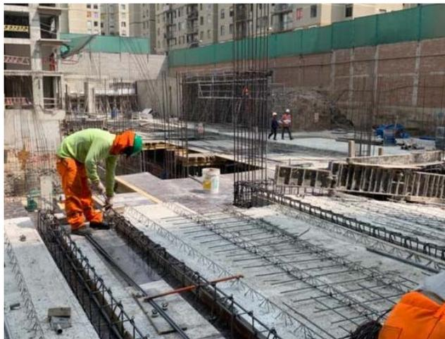
Figura 14: Armado de acero en prelosas. Fuente: Registro fotográfico del proyecto.
