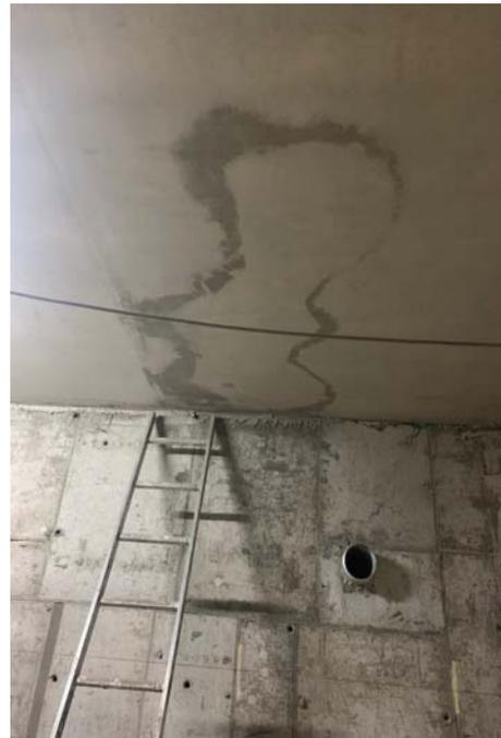
*Figura 44: Fisura en prelosa. Fuente:
