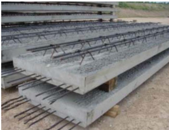
*Figura 1: Pre losas reforzadas o armadas. Fuente: ANDECE (2015)*
