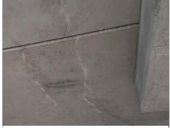
*Figura 46: Fisura en prelosa. Fuente:*
