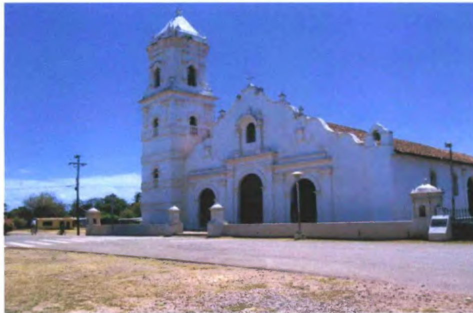
Iglesia colonial Santiago Apóstol de la ciudad de Natá.
