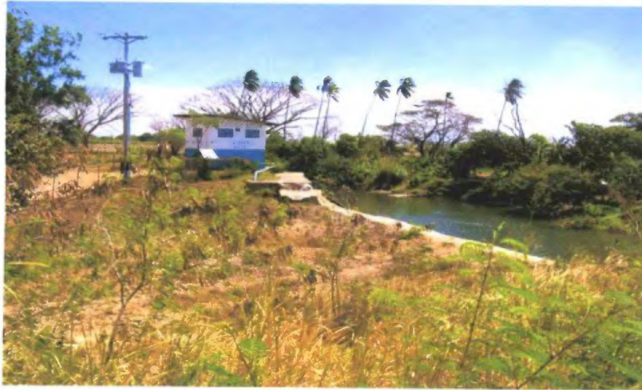
Toma de agua de la planta potabilizadora de Natá.
