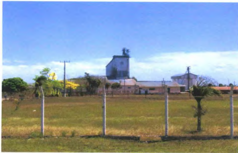
Instalaciones del Ingenio OFELINA, ubicadas en el corregimiento de Capellanía.
