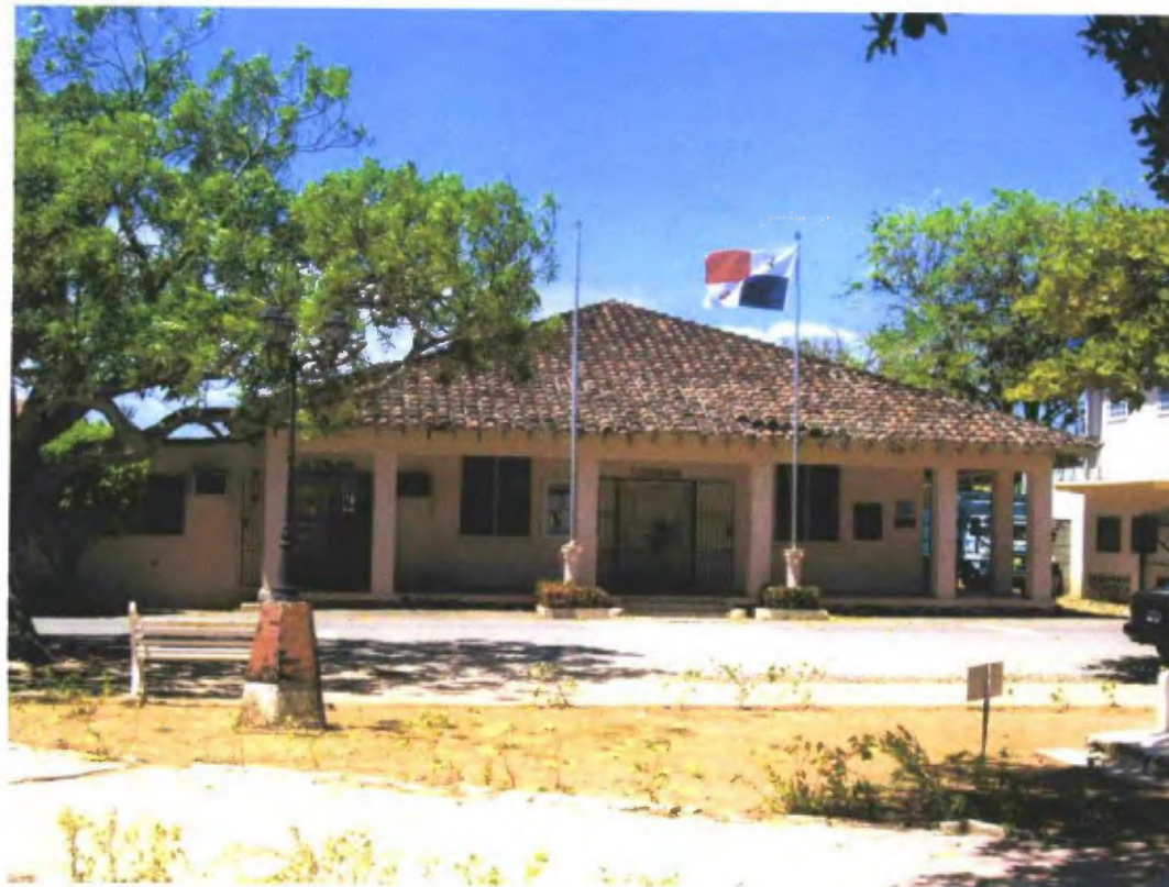
Instalaciones municipales del distrito de Natá.
