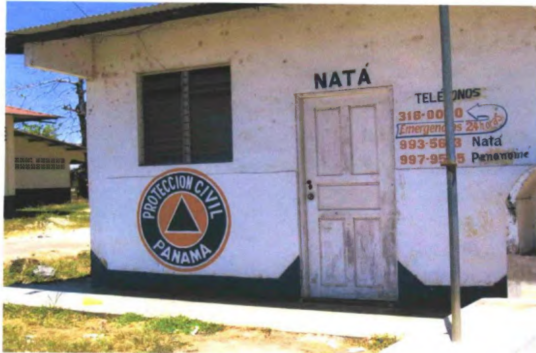
Instalaciones de algunas de las instituciones de seguridad (Protección Civil, Cuerpo de Bomberos) del Distrito de Natá.
