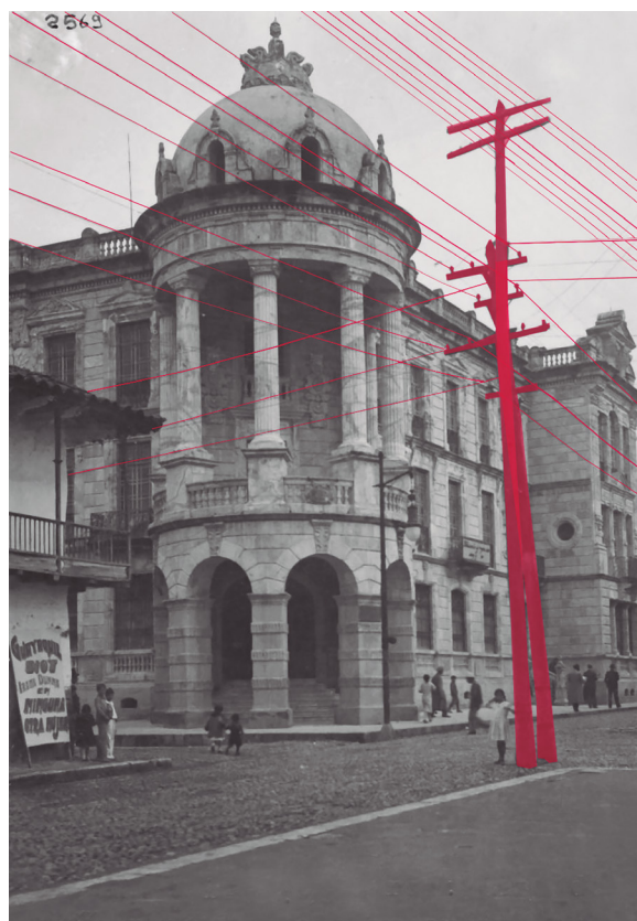
FIGURA 3. CALLE BOLÍVAR, 1930. SISTEMA DE CONDUCCIÓN ELÉCTRICO AÉREO
