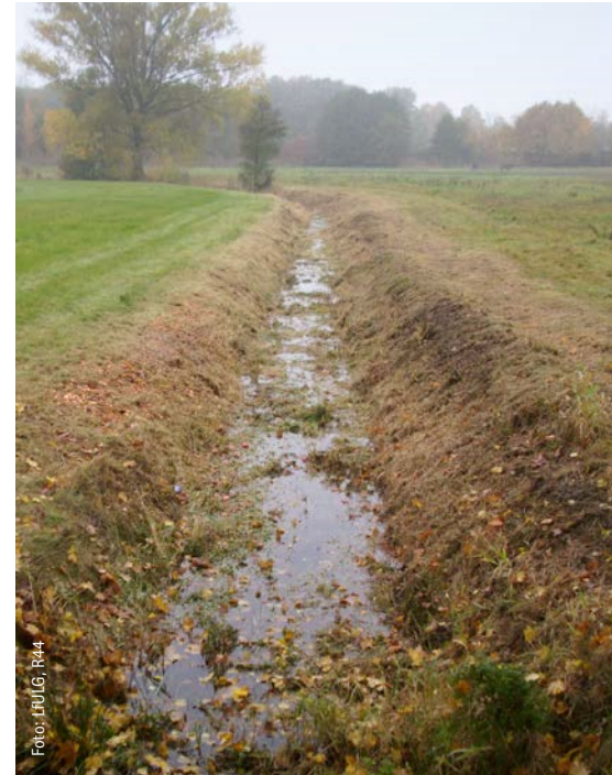
BERÄUMUNG | Totalberäumung eines begrädigten Gewässers
