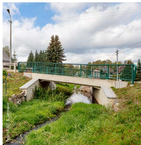
GEWÄSSERDURCHGÄNGIGKEIT | innerörtliche Brückenbaumaßnahme zur Verbesserung der Gewässerdurchgängigkeit
