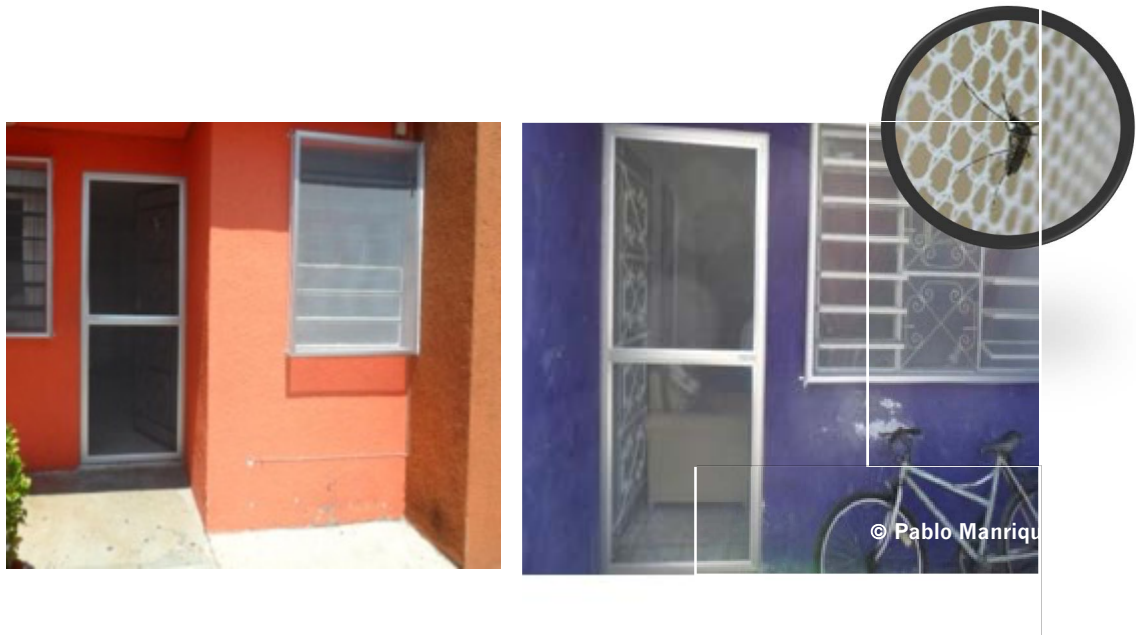
Mallas mosquiteras impregnadas con insecticida de larga duración en puertas y ventanas de casas en Mérida, Yucatán.
