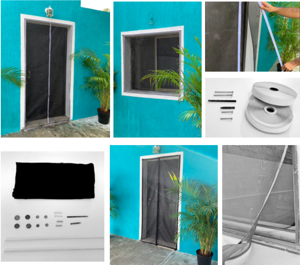
Alternativas de colocación de mallas mosquiteras con uso de velcro e imanes a utilizar en la fase comunitaria de proyecto colaborativo a implementar en Pochutla, Oaxaca.
