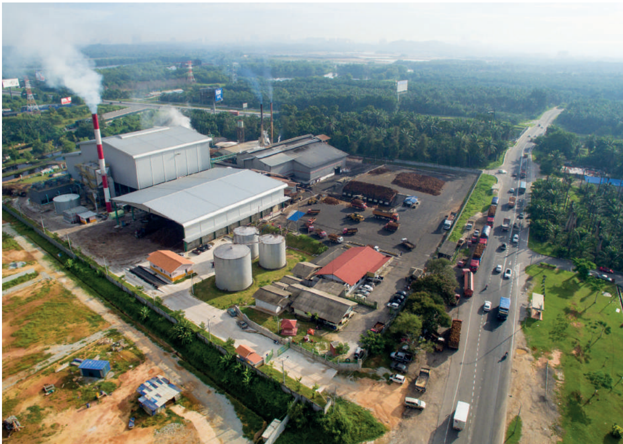
A 7MW Biomass Plant-Tenaga Sulpom Sdn Bhd, Dengkil, Selangor under the FiT programme.
