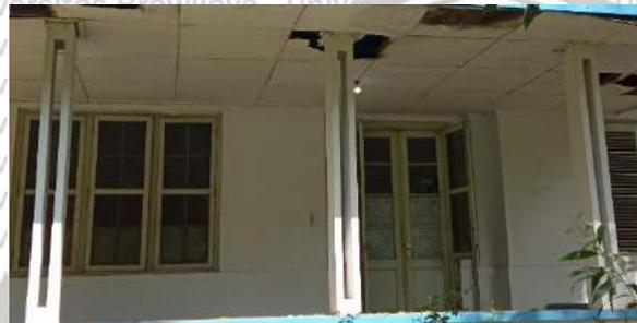
Konstruksi kayu sebagai kolom ekpos bangunan yang menahan atap pada teras
