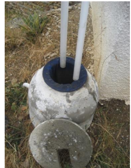
SCAGTANCANNA DO BHAILIÚ BÁISTÍ / RWH FILTER TANKS
