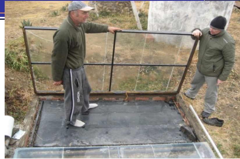
Téitheoir uisce gréine le pláta – níos éifeachtaí / Solar water heater with plate fitted to improve efficiency
