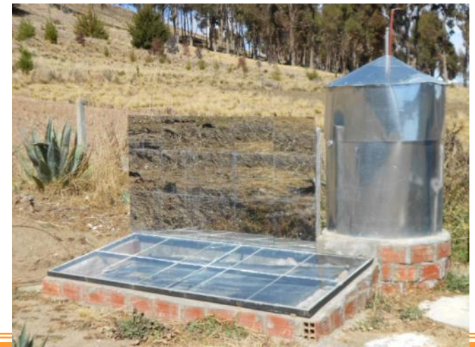
Téitheoir uisce gréine le pláta – níos éifeachtaí / Solar water heater with plate fitted to improve efficiency
