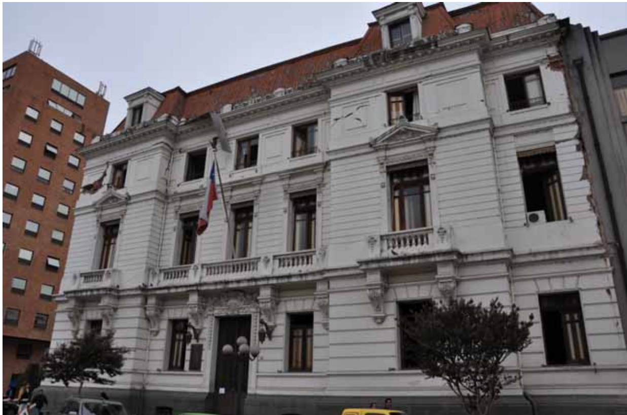
Figure 4.26 Edificio Intendencia Maule in Talca
