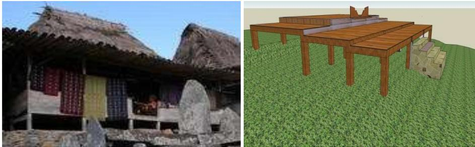
Gambar 9. Penerapan sistem kolom pada rumah adat (*Sa'o*)
