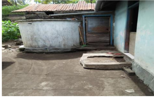
Gambar 1. Kondisi Penampungan Air hujan Di Pulau Ende
