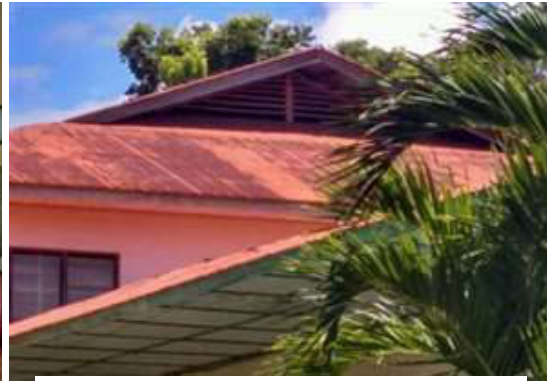
Gambar 5. Ventilasi atap, ada 1 buah.
