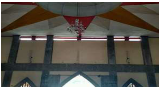
Gambar 2. Ventilasi yang letaknya paling atas, ada 8 buah.
