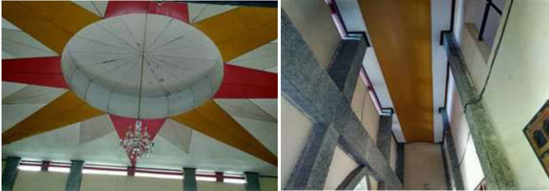
Gambar 11. Plafon dari triplek yang dimodifikasi.
