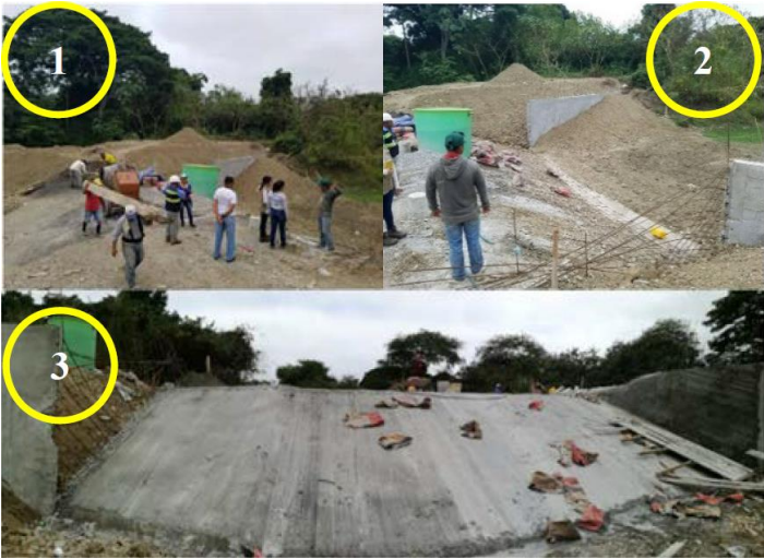
Figura 2.10. Fases de construcción del tapes/dique técnico artesanal. Fuente: (Carrión et al., 2018)
