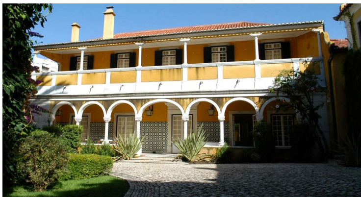
Fig. 1 – Palácio da Terrugem, alçado principal/sul, em set. 2009. (CMO)
