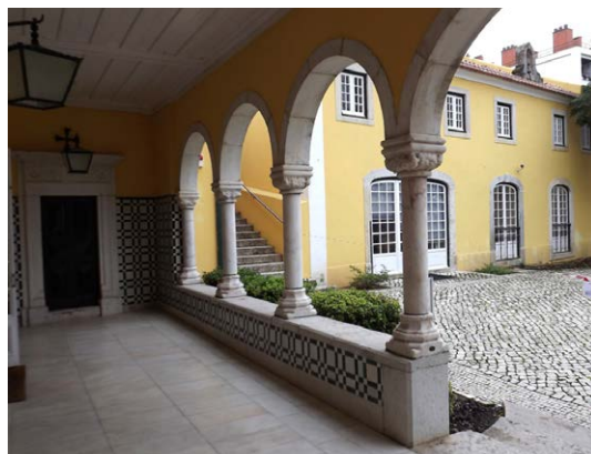
Fig. 7 – Vista parcial da loggia , porta de acesso à capela e as colunas com os capitéis 5 a 8, em nov. 2013. (ACA)
