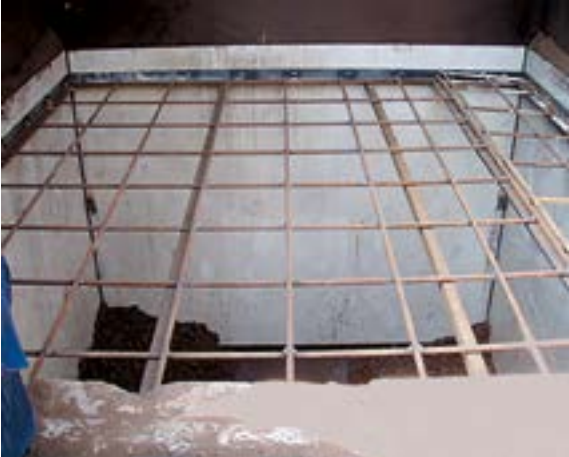
Kuva 7. Putoamisvaaraa voi torjua mm. asentamalla varastoon suojaverkon (YTOT 1/09).
