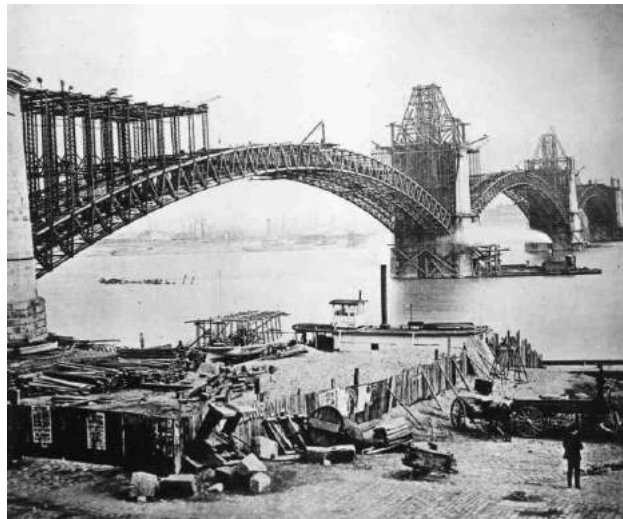
Figure 52 : Le pont Eads en cours de construction vers 1874 (Wikipédia)
