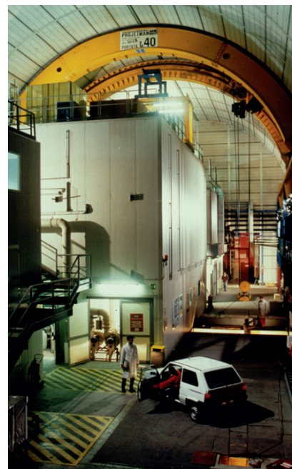
Abbildung 5. GALLEX-Prozessgebäude für die Detektortanks und die Chemieanlagen zur Ge-Abtrennung in Halle A des Gran Sasso Untergrundlabors, Italien.
