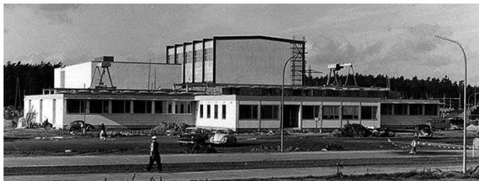
Abbildung 1. Rohbau des Instituts für Heiße Chemie (IHCh) 1962 auf dem Gelände der Gesellschaft für Kernforschung (GfK) in Karlsruhe. Die Gebäude im Hintergrund sind rechts die Technikumshalle, links das Lüftergebäude, im Vordergrund der Flachbau mit radiochemischen Laboratorien und Heißen Zellen.
