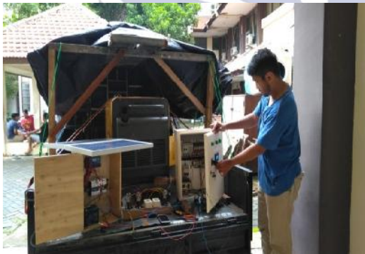
Gambar 10. Menyiapkan komponen komponen ATS AMF untuk di ujicoba
