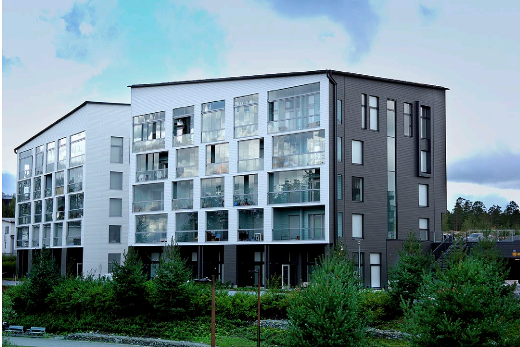
Kuva 6. Tampereen Vuoreksen Tervaskadulla 2020–2021 valmistuneiden kerrostalojen asunnot sijoittuvat keskikäytävän molemmin puolin. Rakennuksen kahdella julkisivulla on lasitetut parvekkeet.
