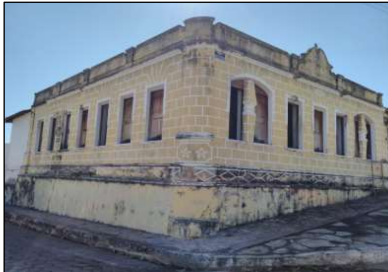
Figura 1 – Fotografia da construção que abriga o Museu Histórico e Cultural de Arraias, 2021.
