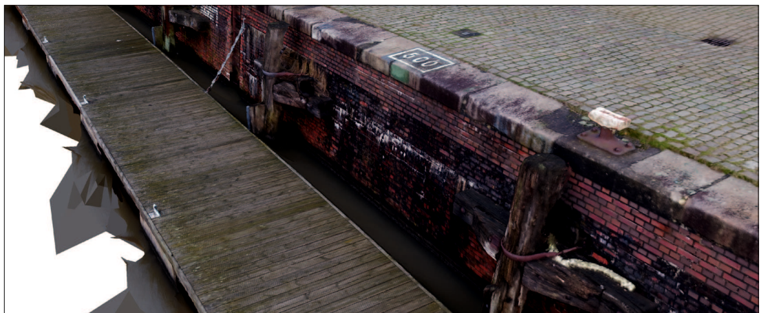
Abb. 3: Ergebnis einer Kaimauerinspektion mit Überflügen in drei unterschiedlichen Höhen, dargestellt mit RealityCapture
