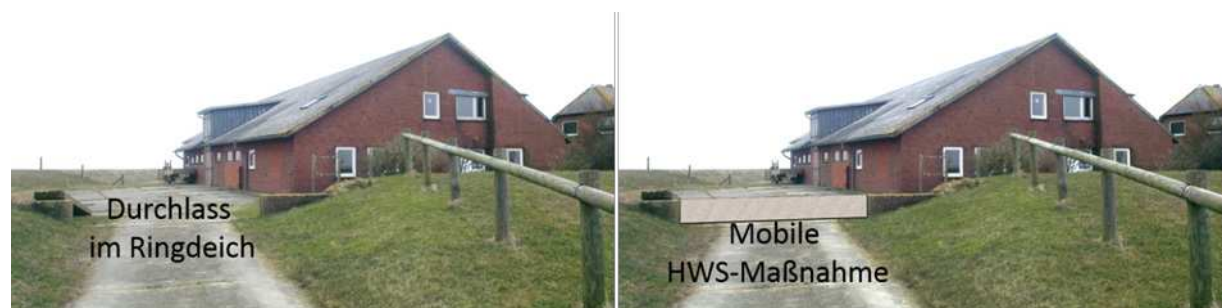
Abbildung 1: Möglicher Einsatz einer mobilen HWS-Maßnahme zum Verschluss einer Stöpe.
