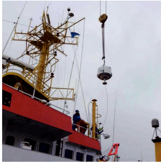
Abb. 9: Einbau einer VSAT-Antenne auf VVWS »Deneb«
