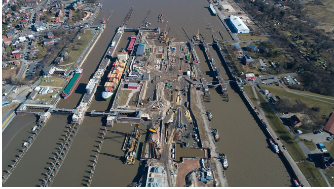
Bild 1 Baustelle der fünften Schleusenammer auf der Schleuseninsel (Jahr 2018) Construction site of the 5 th lock chamber between the existing locks (year 2018)
