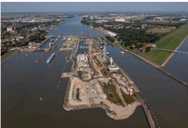
Abbildung 1: Baustelle der 5. Schleusenkammer (Jahr 2021)
