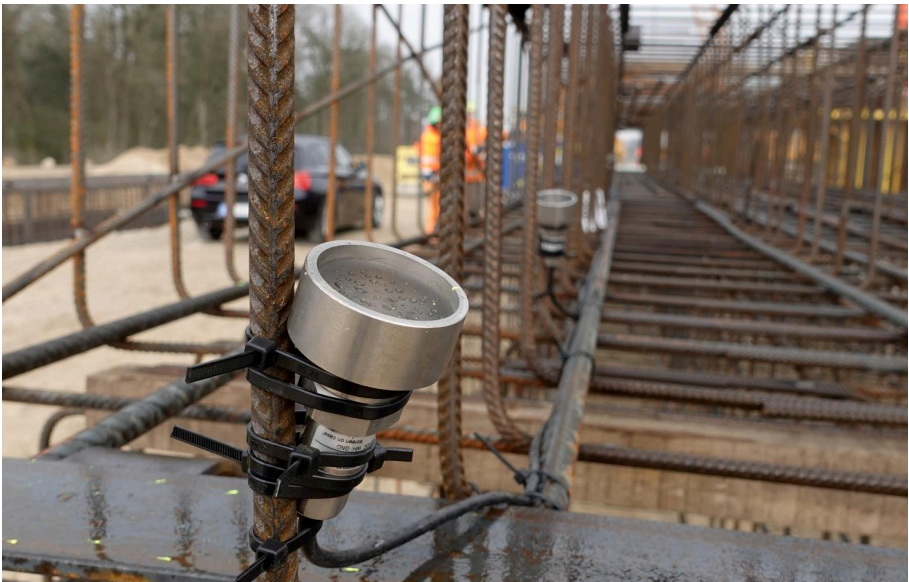
Abbildung 12: Ausrichtung und Befestigung der Sensoren am Bewehrungskorb
