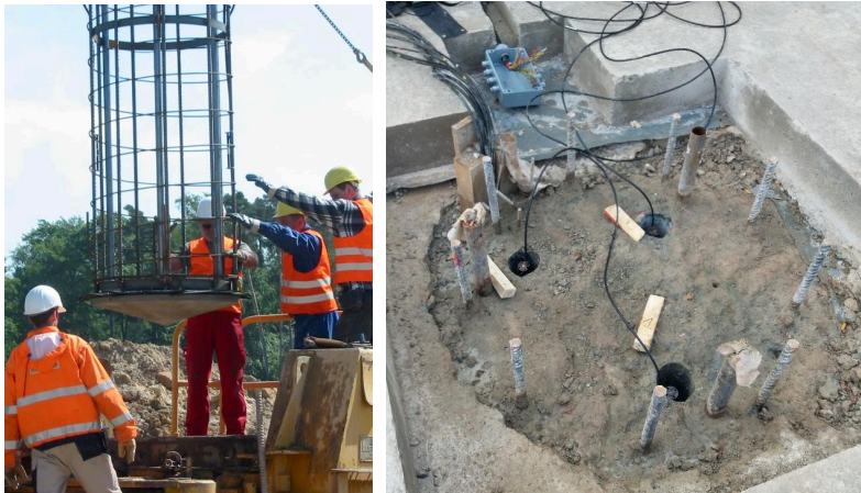
Abbildung 8: Einbau einer Pfahlkraftmessdose , Kernbohrungen mit drei Dehnungsmessgebern am Pfahlkopf
