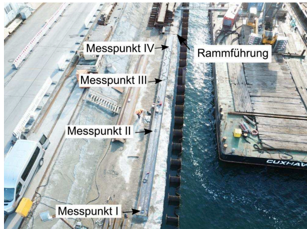
Abbildung 2: Versuchstragbohle HZ 1180M A - 12, S 430 GP
