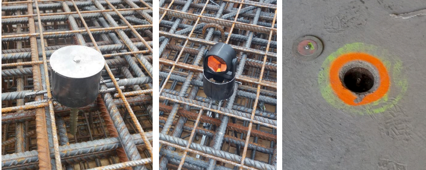
Abbildung 7: Geodätischer Messpunkt vor und nach der Betonage
