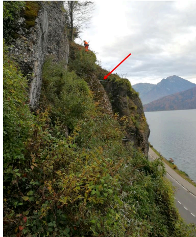
Abbildung 8: Spare-Felswand Roter Pfeil zeigt Verschiebungsgeber
