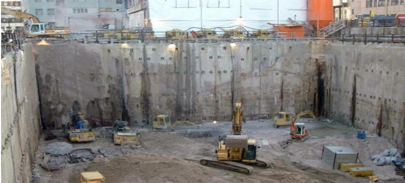
Abbildung 5: Freigelegte Schlitzwand mit Wasserdruck
