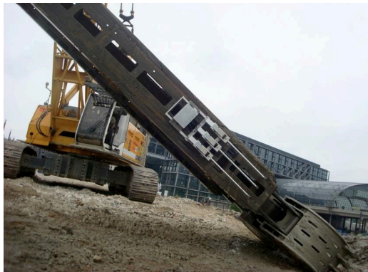
Abbildung 18: Fugeninspektor montiert am Greifer
