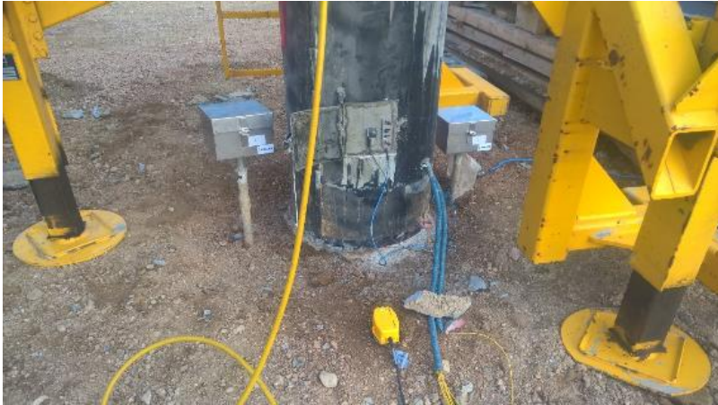
Abbildung 13: Ausrüstung bei den dynamischen Probelastungen
