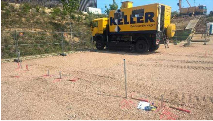
Abbildung 11: Vorab eingebautes Piezometer auf dem Testfeld
