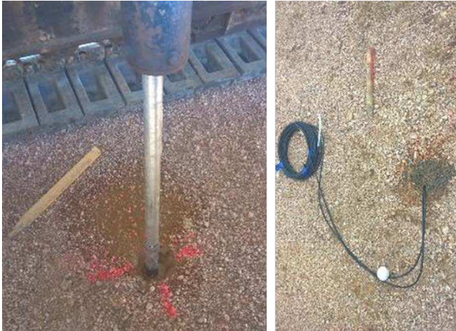
Abbildung 12: Einbau eines Piezometers (links) und eines kombinierten Porenwasser-Erddruckgebers (rechts)
