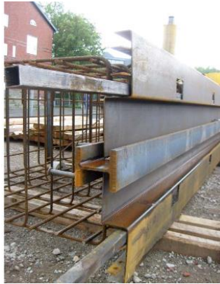
Abbildung 32: Zwangsführung am Bewehrungskorb
