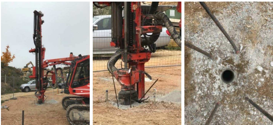
Abbildung 8: Bohrvorgang zur Instrumentierung der Messtechnik – Bohrung mittels Sprenglochbohrung (links), Bohrloch im Traggliedzentrum mit Steckeisen zum Anschluss des Belastungskopfes (vgl. Abb.13) (rechts)
