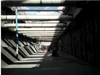
Abbildung 11: ausgesteifter Verbau und zugehöriges Messprogramm
