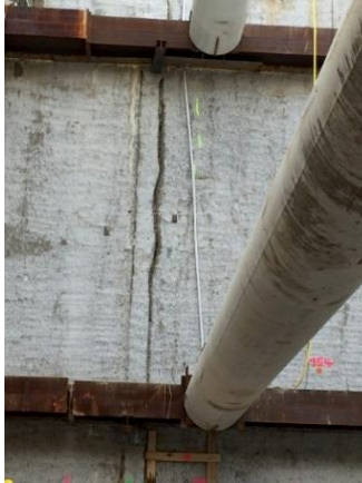
Abbildung 21: Umlaufbeton hinter der Fugenkonstruktion
