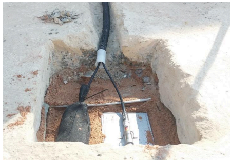
Abbildung 10: Porenwasser- und Sohldruckgeber
