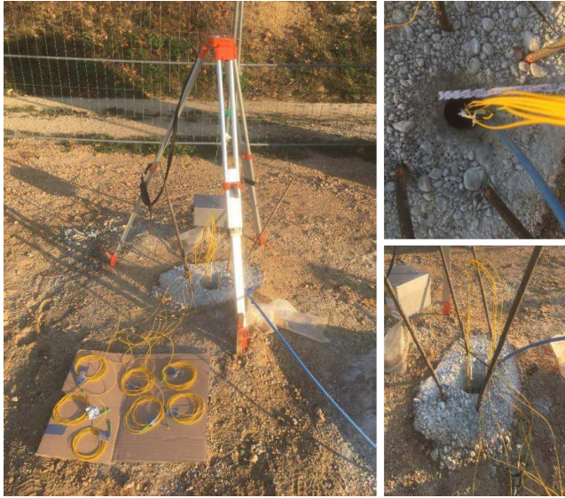
Abbildung 8: Einbau der FBG-Sensoren
