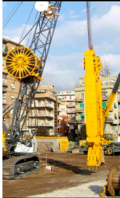
Abbildung 2 : Hydraulischer Greifer
