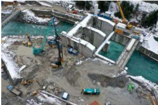
Abbildung 12: Bauzustand Stauwehr Ovella Nov. 2019
