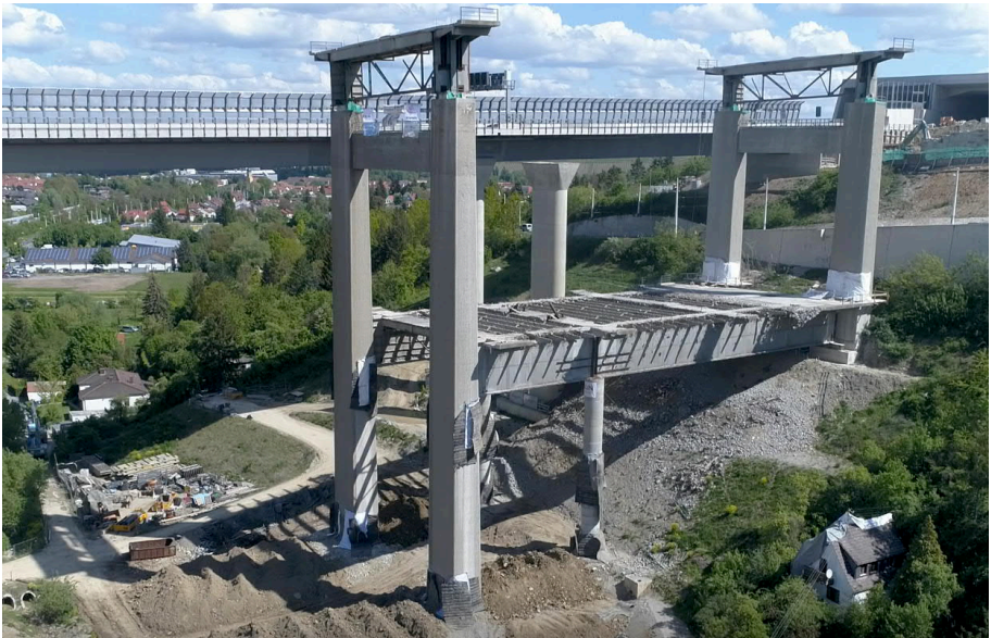
Bild 2: Sprengvorbereitungen Talbrücke Heidingsfeld
