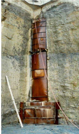
Abbildung 6: Verpresste Schlitzwandfuge
