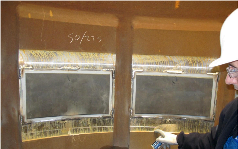
Abbildung 3: Umlaufend angeordnete Spacer Plates mit Teflonauflage im Inneren des Jacketbeins
