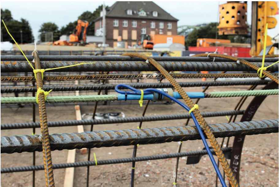
Abbildung 12: Dehnungssensoren (sister bars) am Bewehrungskorb
