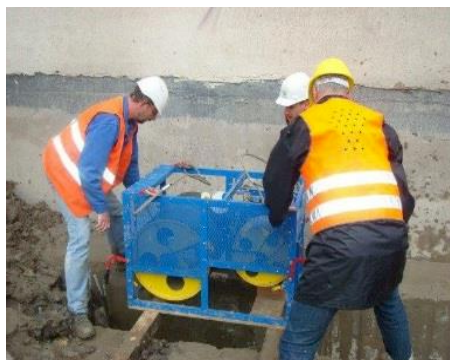
Abbildung 14: Kodenmessgerät im Einsatz
