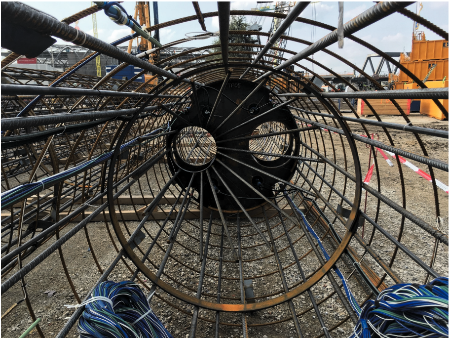
Abbildung 16: Führungstrichter oberhalb der O-Zelle
