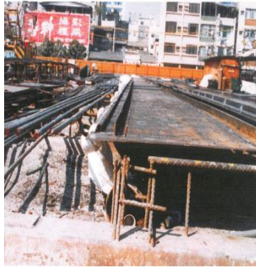
Abbildung 34: Bewehrungskorb mit Stahlblech
