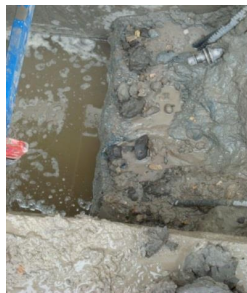
Abbildung 31: Überfräste Fuge
