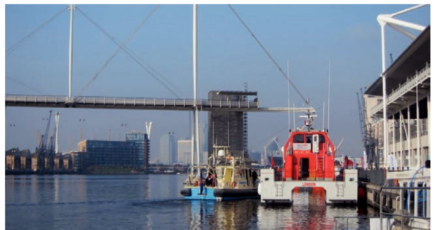
Die ExCeL-Ausstellungshalle (links) und die Royal Docks
