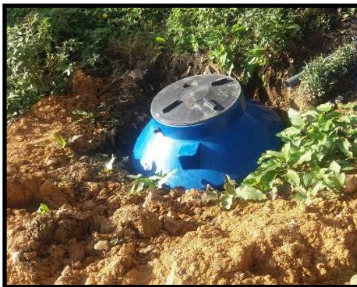
Figura N° 06: Implementación de tanques para la elaboración de biol con residuos del agua del beneficio húmedo.
