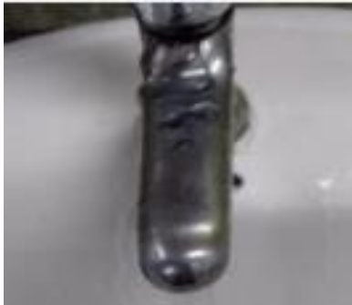
Figura 28: Fuga desde el botón del temporizador en el baño principal para damas del primer piso
