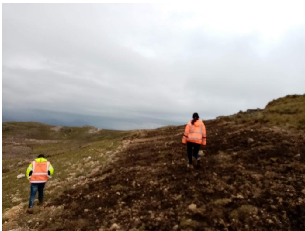
Foto 2: Trabajos de rehabilitación en Antonio de Chuco.
