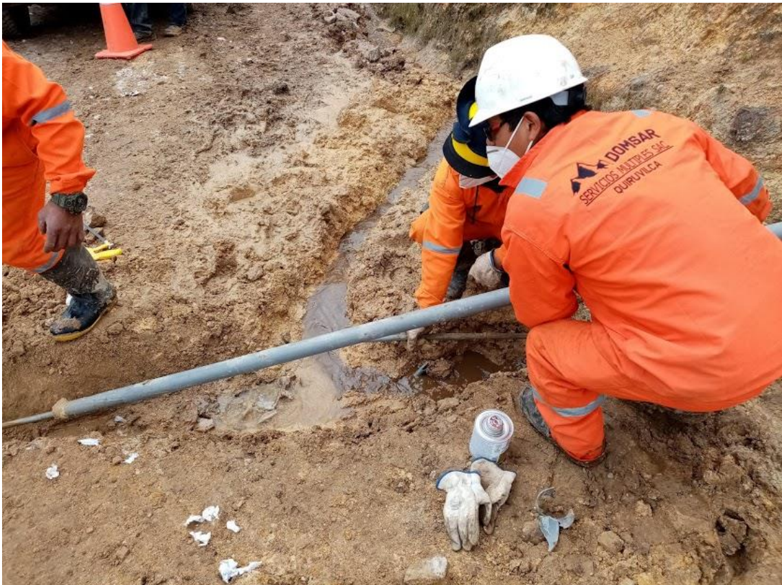
Foto 4: Labores de alcantarillado a favor de la comunidad.
