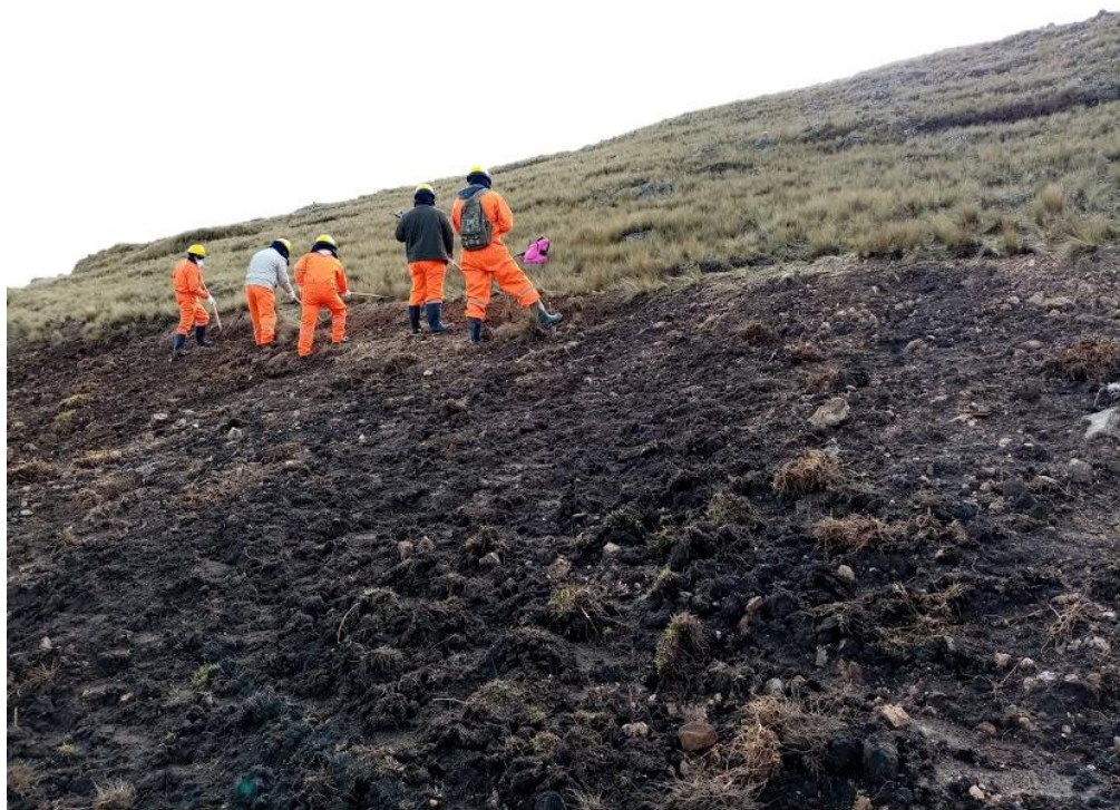
Foto 1: Trabajos de rehabilitación en La Capilla.
